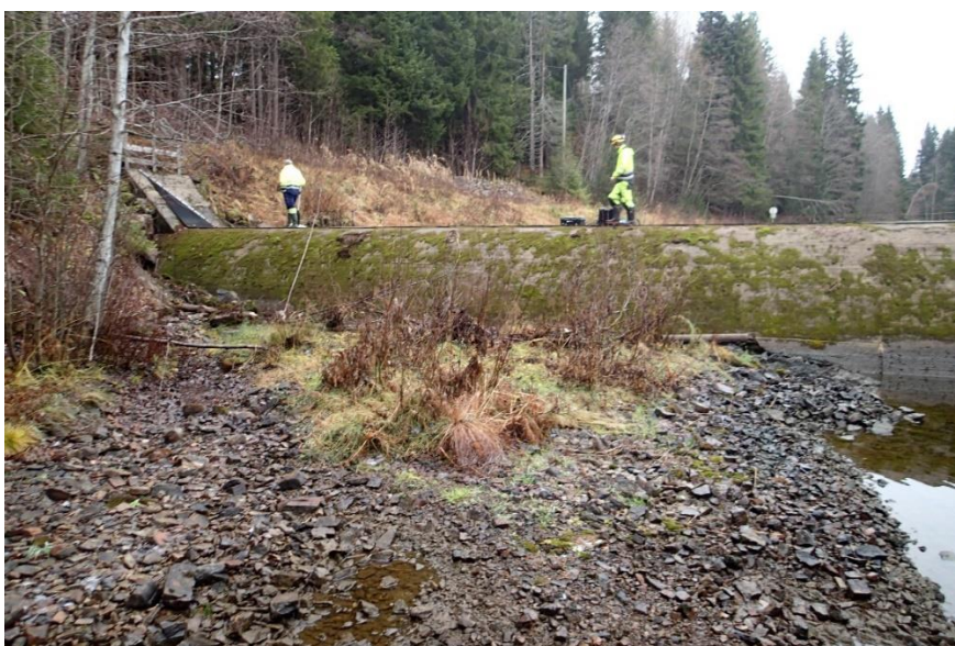
Figur 3-4. Området nedstrøms hvor det skal renskes og støpes.
