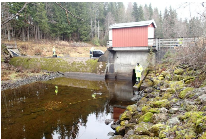
Figur 1-2. Dammen sett fra nedstrøms side.
