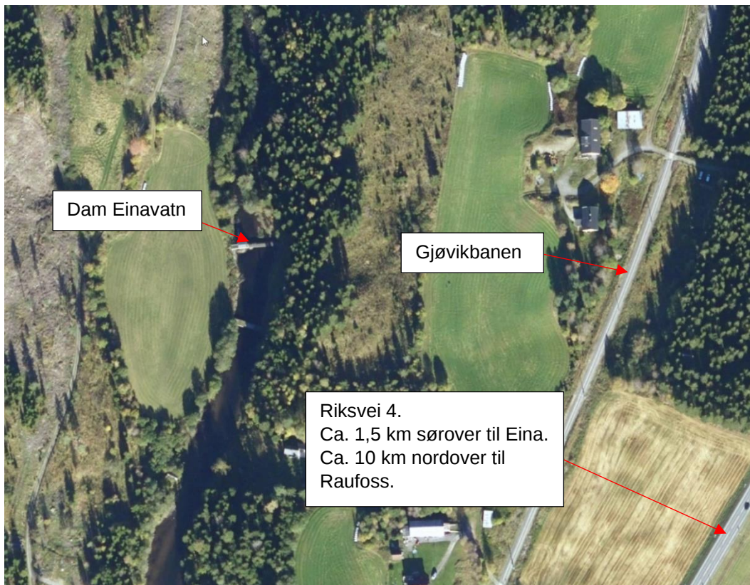
Figur 1-3: Flyfoto over området ved anlegget.
