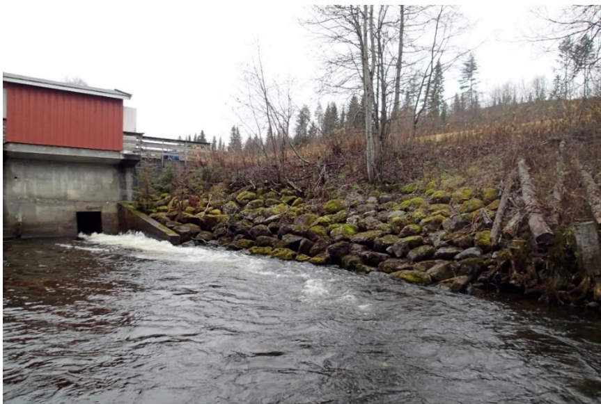
Figur 3-3. Midlertidig anleggsvei legges i skråningen til høyre i bildet.
