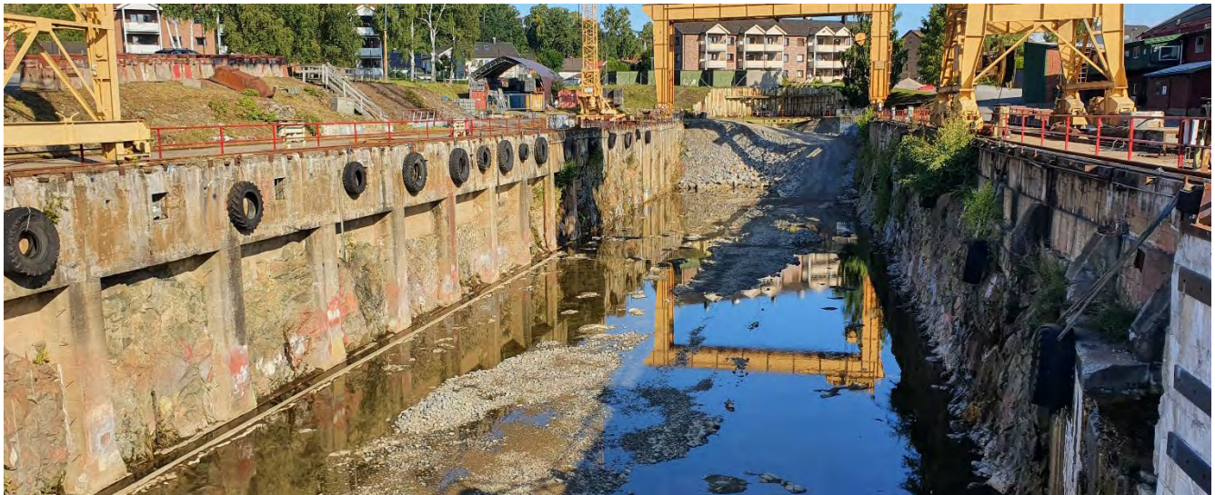
Figur 3. Bilde av tørrdokka fra befaring den 02.09.2020.
