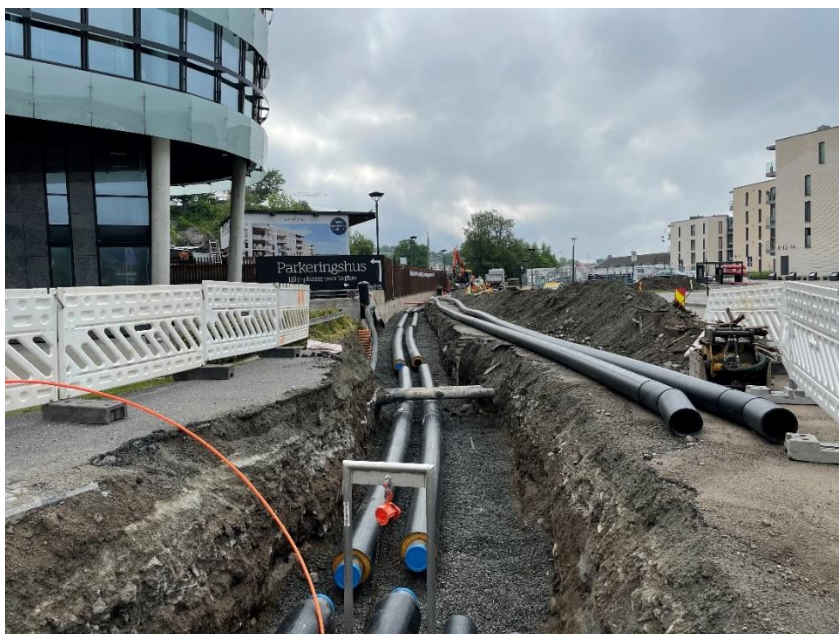
Figur 7-3 Hammerdalen Fjernvarme fremfører i juni 2021 fjernvarme og fjernkjøling i fylkesvei 103 Sanden
