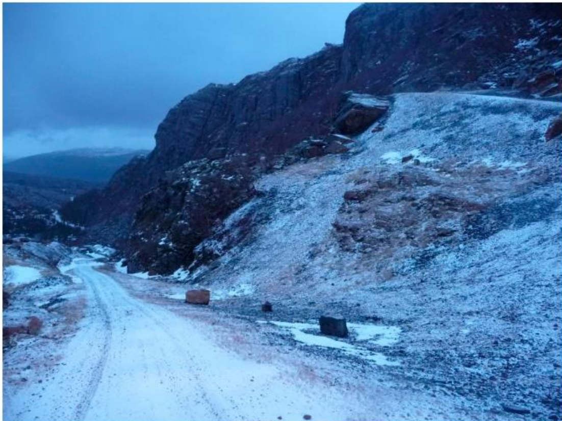
Tilkomstvegen til dam Bjørndalsvatn og tverrslag overføringstunnel. Røygata vil etablerast nedgravd i vegen.
