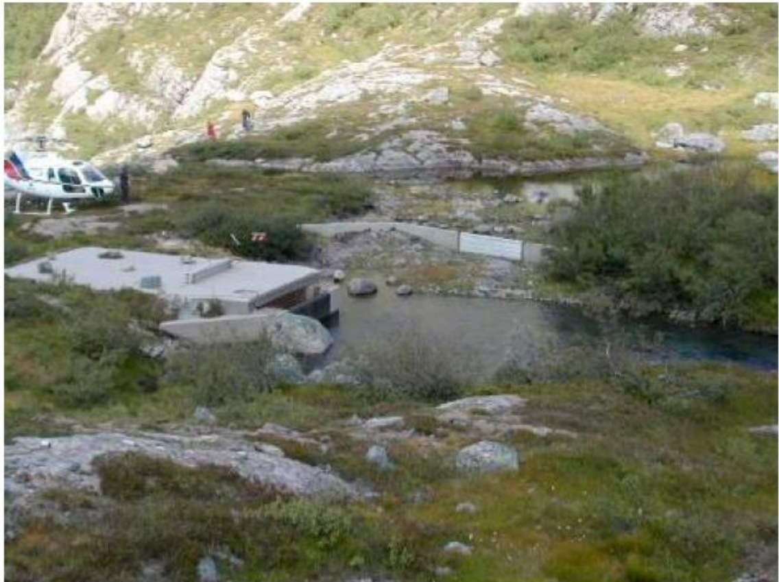
Dagens inntak Insteelva.
