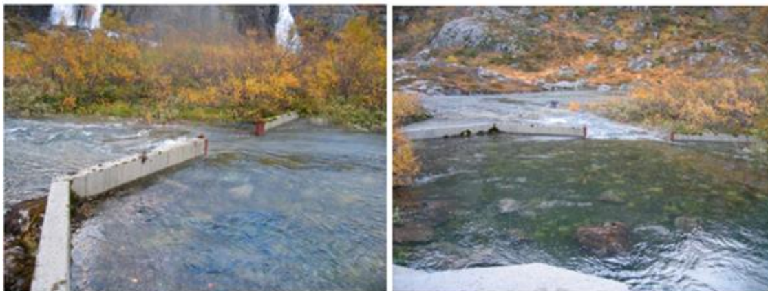
Bileta viser eksisterande sperredam ved satt bjelkestengsel i inntak Insteelva.
