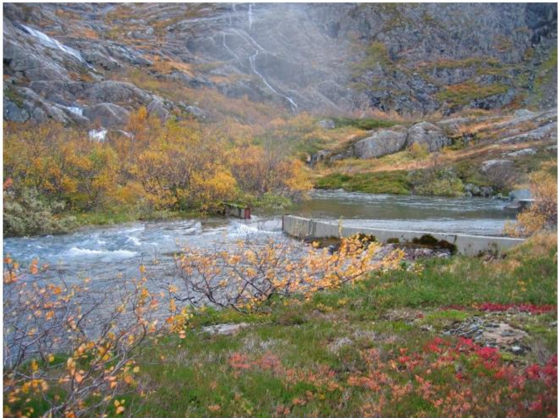
Dagens sperredam med satt bjelkestengsel i inntak. Inntak til høyre i bildet.
