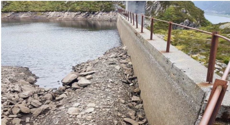
Figur 9: Bildet av dammen sett fra oppstrøms side. Vannstand ca kote 119.
