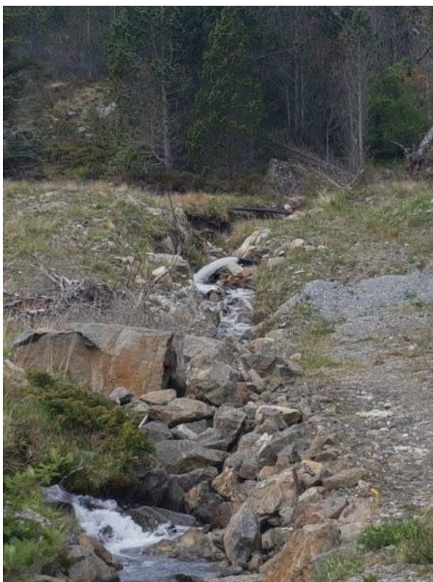
Avløp fra rør nedstrøms dam Vikavatnet (kote 65)
