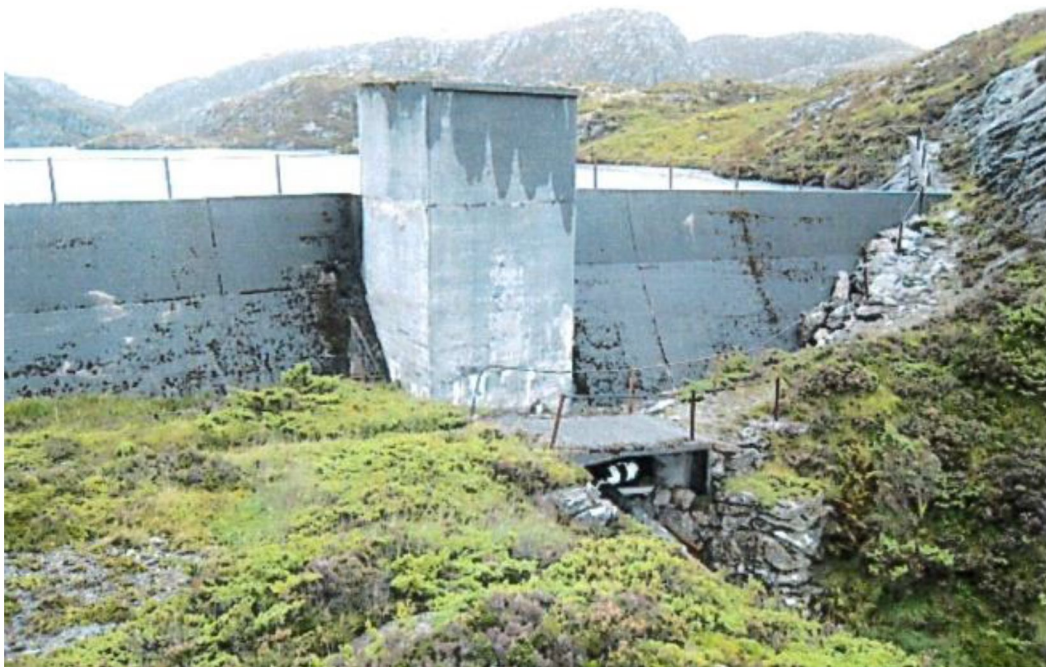
Figur 31: Sti og gangbru nedenfor dam Igesundvatnet
