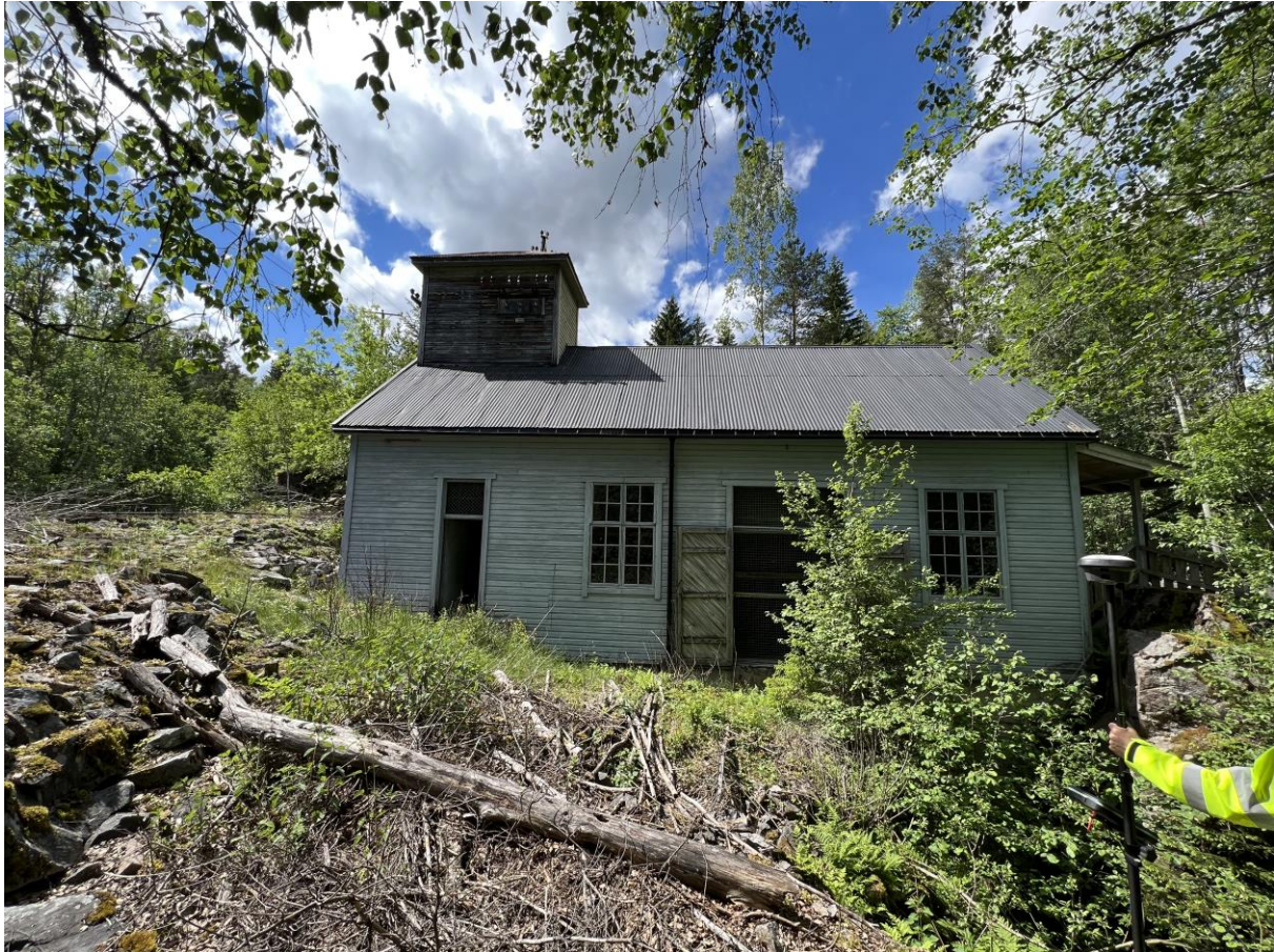
Bilde 4. Oterholtsfoss kraftverk sin kraftstasjon. Ny kraftstasjon blir bygd til høyre for denne.
