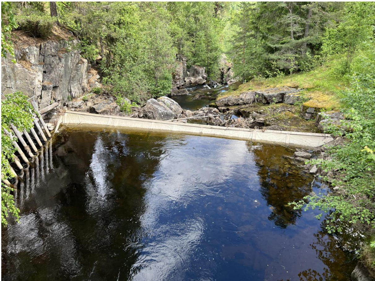
Figur nr 3. Eksisterande trebukkadam og tunnelmunning med sperre av grove trestokkar. Vatnet nedstraums dammen skuldast lekkasje i dammen. Nytt inntak vil bli bygd der tunnelmunningen er. Trebukkedammen blir erstatta av betongdam som blir vinkla noko meir inn i inntakskulpen for å leie fisk mot overløp plassert i enden av rista.
