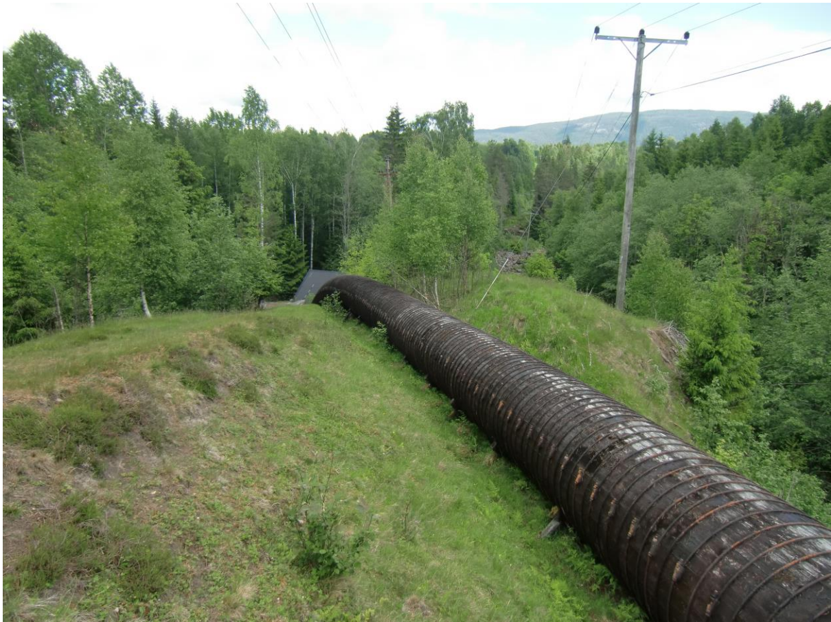
Bilde 3. Eksisterande trerøyr. Nytt røyr vil vere nedgrave til venstre for trerøyrret.
