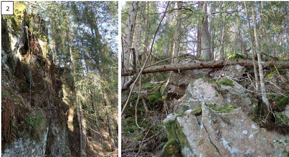
Figur 13. Det er utført fjellsikring i skrenten i minst to omganger. Bildene viser eksempler på at det er sikret med wirenett flere steder. Sannsynligheten for at det skal rase ned blokker fra skrenten er svært lav så lenge fjellsikringen vedlikeholdes.
