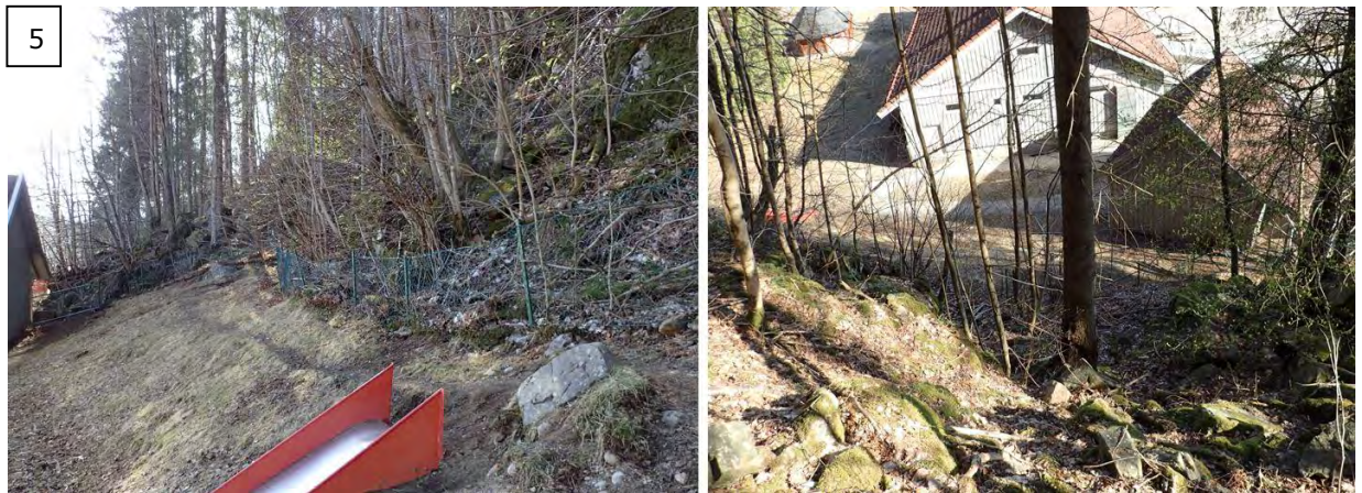
Figur 17. I overgangen mellom skrent og opparbeidet areal ved barnehagen ligger det stedvis noen blokker inn mot flettverksgjerdet som er satt opp. Det er derimot ingen tegn til at gjerdet er skadet som følge av at steiner har rast på nettet eller stolpene. Det ligger et mindre antall «ferske» rasblokker noen meter ovenfor gjerdet (sannsynligvis som følge av rotvelt), men ingen i eller ved gjerdet.
