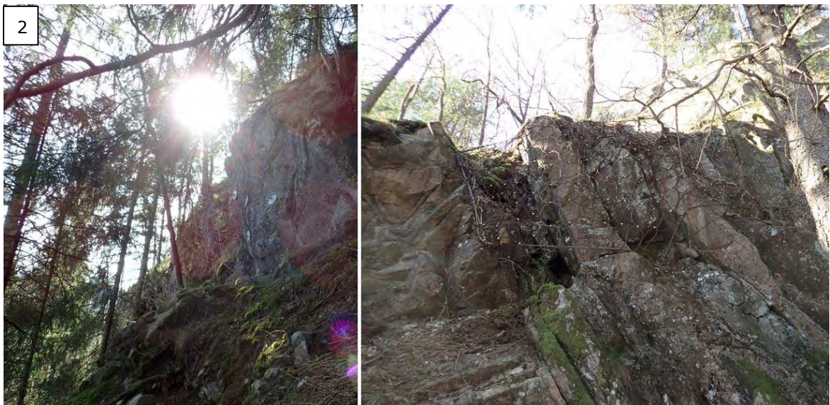
Figur 12. Det er utført fjellsikring i skrenten i minst to omganger. Bildene viser eksempler på at det er sikret med både bolter og wirenett. Sannsynligheten for at det skal rase ned blokker fra skrenten er svært lav så lenge fjellsikringen vedlikeholdes.
