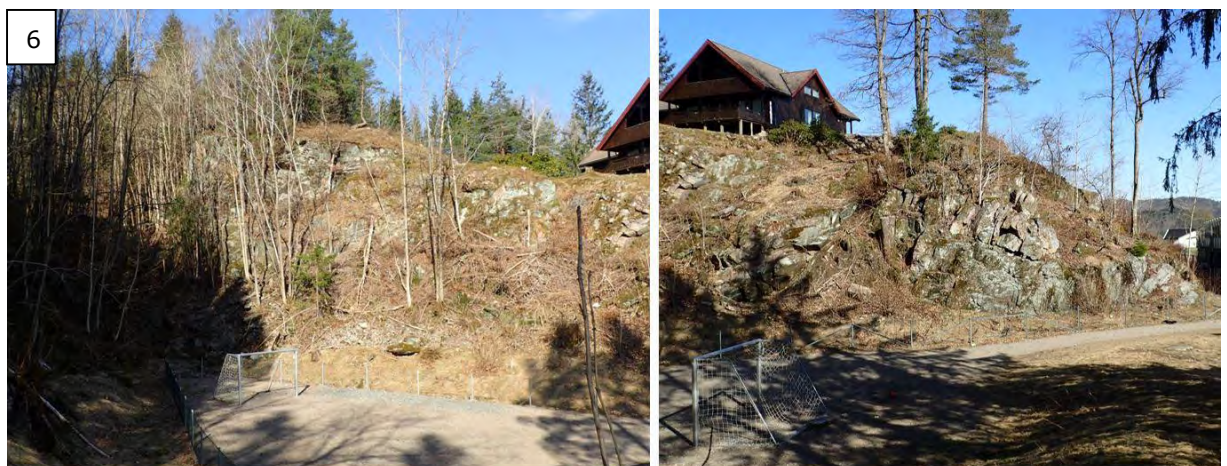
Figur 18. Vestre del av området sett mot nord. Begrenset høyde på terrenget, men det er urdannelse og noe rasfare under skrenten helt i vest, til venstre i venstre bilde.
