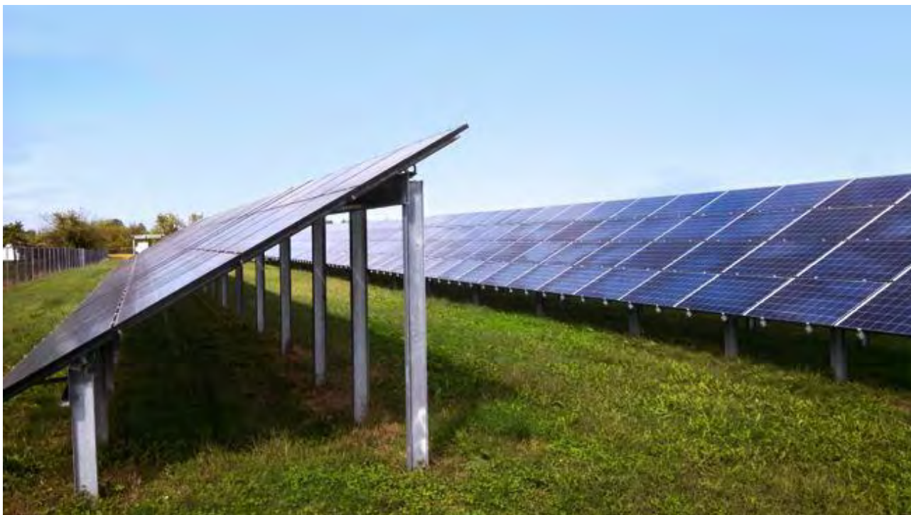
Figur 3-3: Fast-vinkel installasjonsløsning (foto: Willowbrook Solar)
