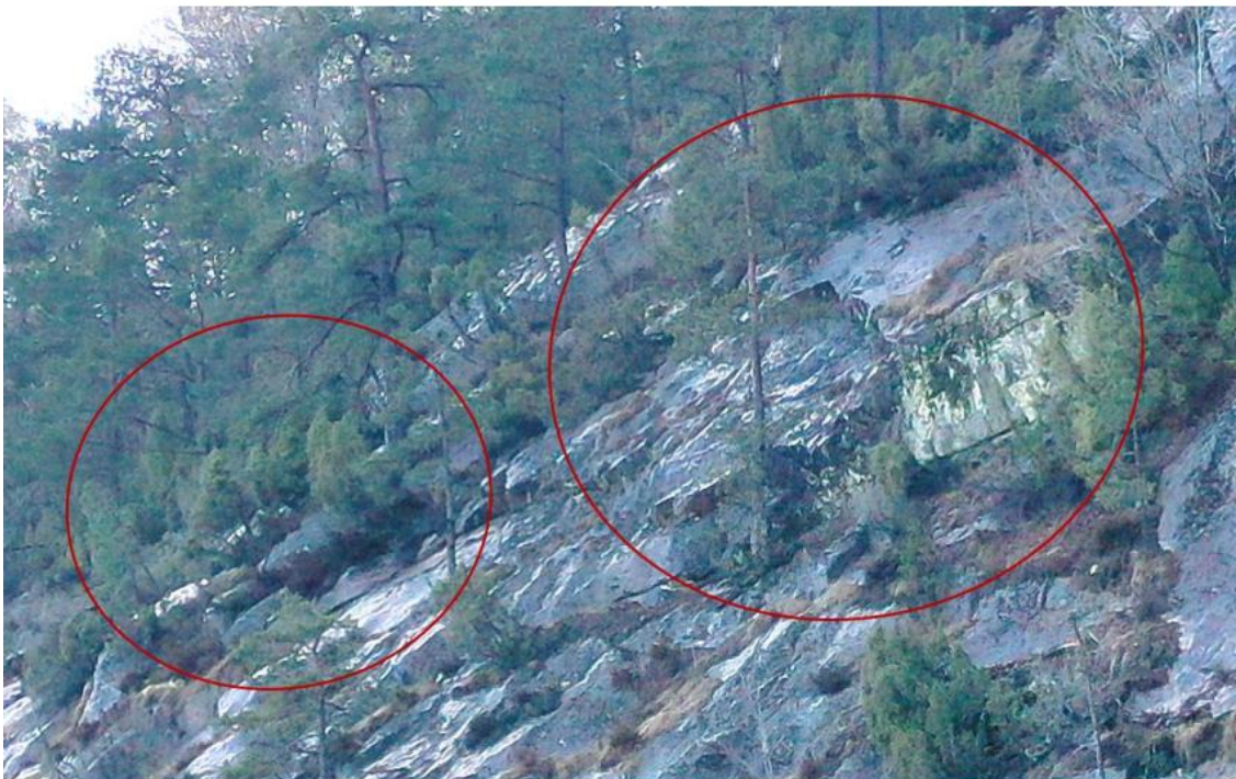
Figur 2 Observerte blokker ved punkt 4 og 5
