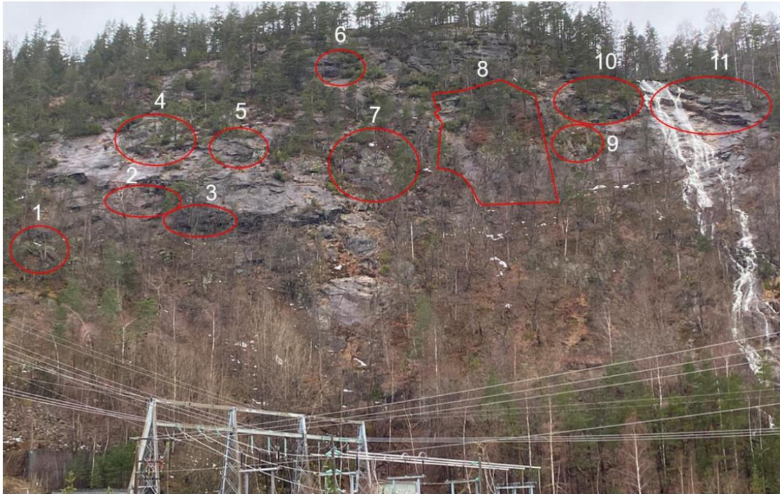
Figur 1 Oversikt over observerte blokker og bergpartier med antatt lav stabilitet
