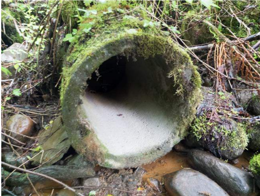
Figur 4: Kulvertrør i betong ved P0.
