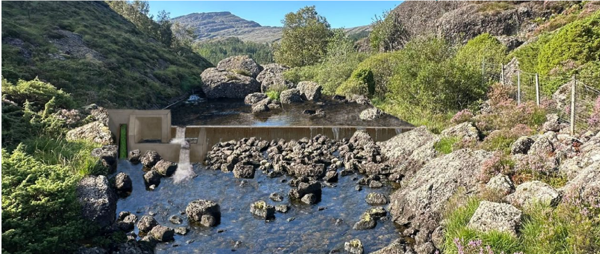
Figur 2 Illustrasjon av dam Storevatn i terrenget. Formål med illustrasjonen er å vise innretninger for vandring av fisk og ål, og viser ikke fullstendig illustrasjon av andre innretninger som arrangement for minstevassføring.
