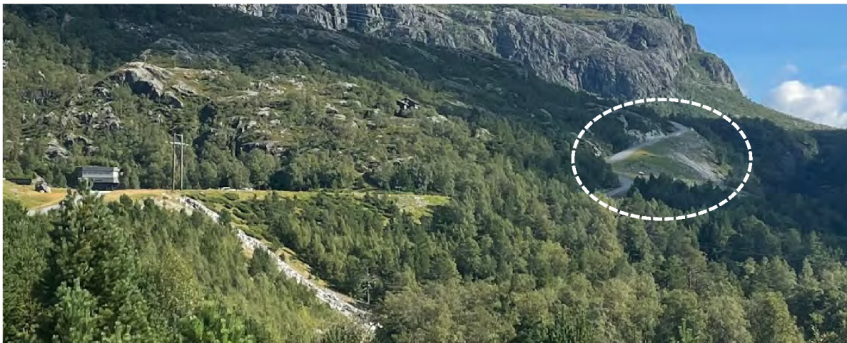
Figur 3-6 Deponi fra 2019 utført som en utbedring av eksisterende skogsbilveg er tydelig eksponert mot dalen og adkomstvegen til Saurdal kraftverk.
