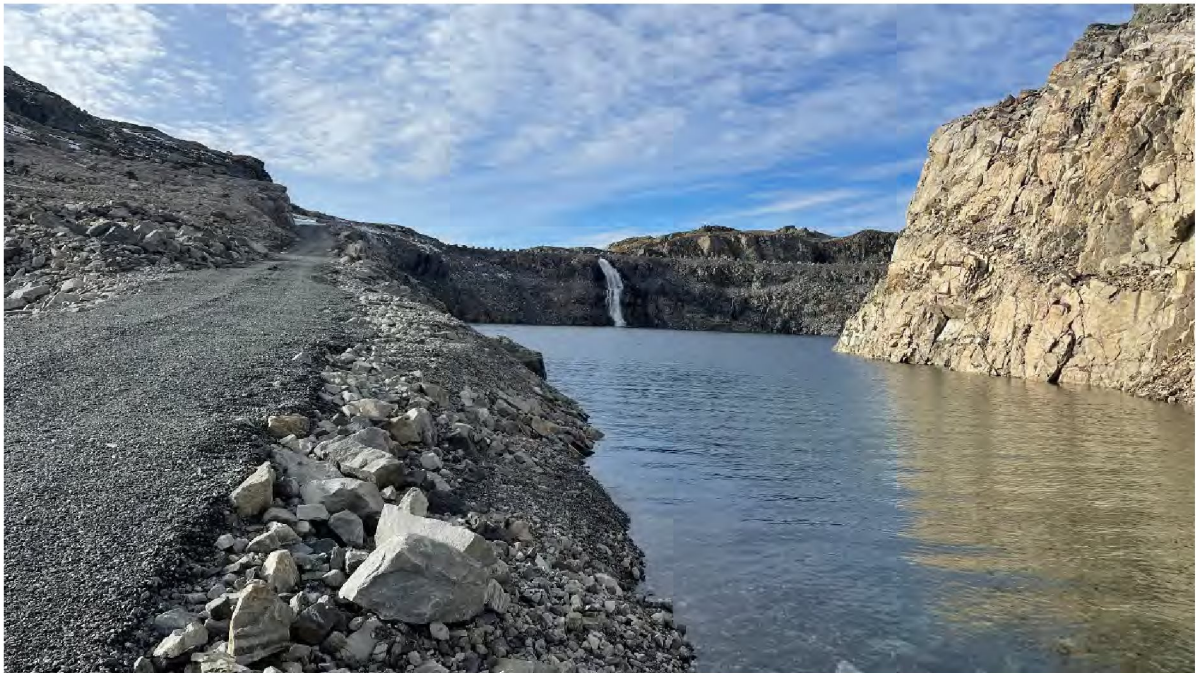
Figur 4-6 Mulig deponi i eksisterende uttak og deponi ved Oddatjørndammen. Vannivået ligger på omtrent 1030 moh. og kanten rundt på rundt +1060 moh.
