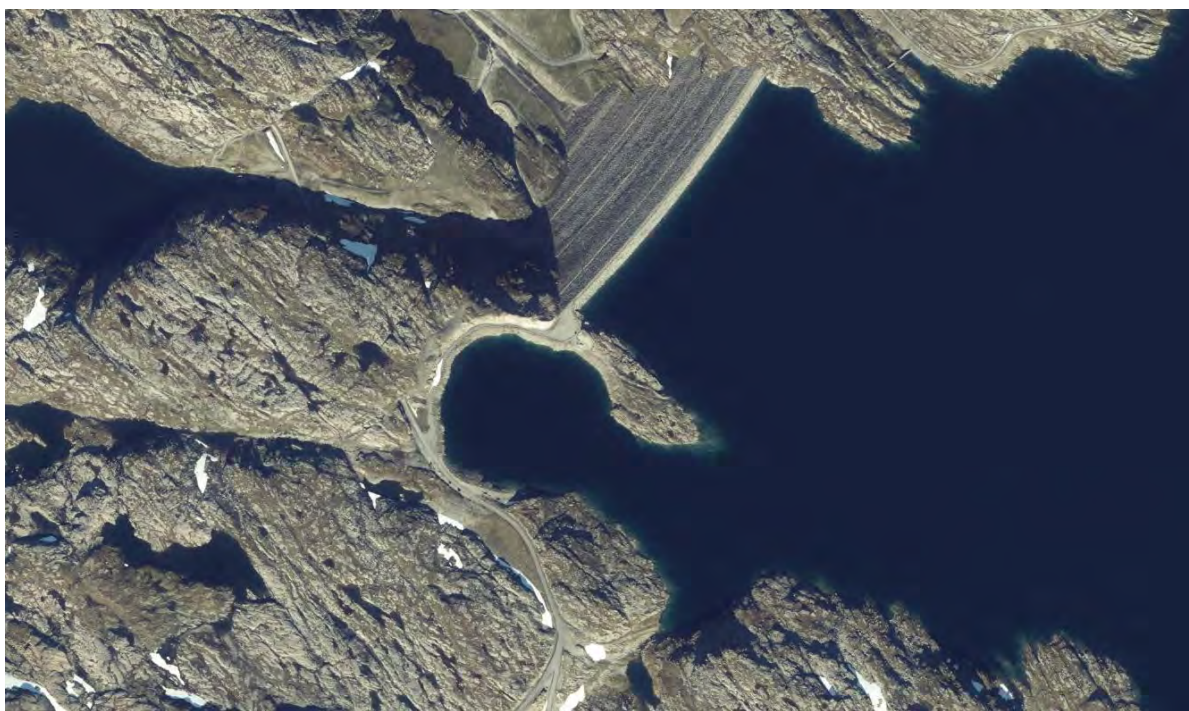
Figur 4-7 Mulig deponi i eksisterende uttak og deponi ved Oddatjørndammen. Området er normalt delvis under vann, men har det siste året vært mer eksponert. Et deponi her vil ikke ha særlig stor påvirkning på landskapsbildet.
