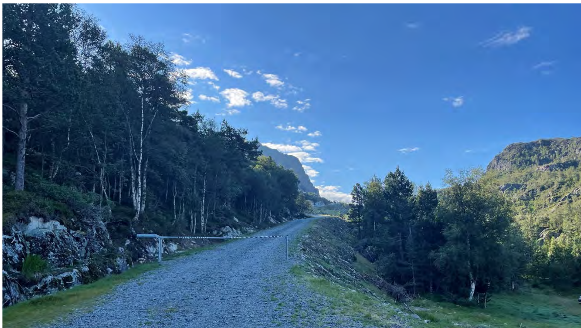
Figur 3-5 Deponi fra 2019 utført som en utbedring av eksisterende skogsbilveg.
