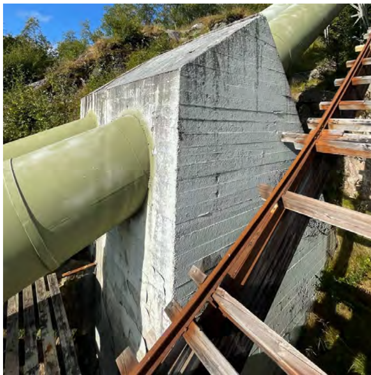
Figur 3 Rør fundament, kalt kloss.
