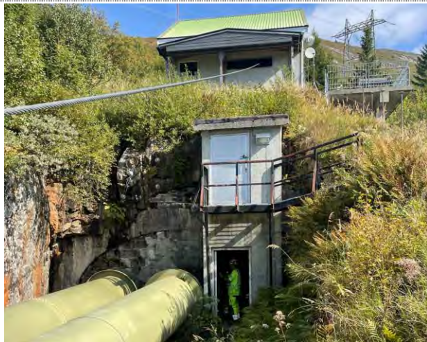
Tunell og inngang rørbruddskammer
