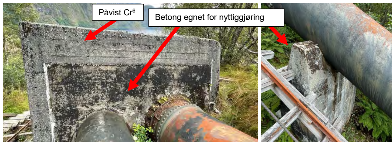
Figur 3 Venstre betongkloss med påstøp. Høyre mindre rørfundament.
