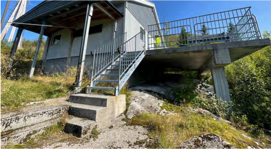
Figur 5 Betong ved spillverkshus.
