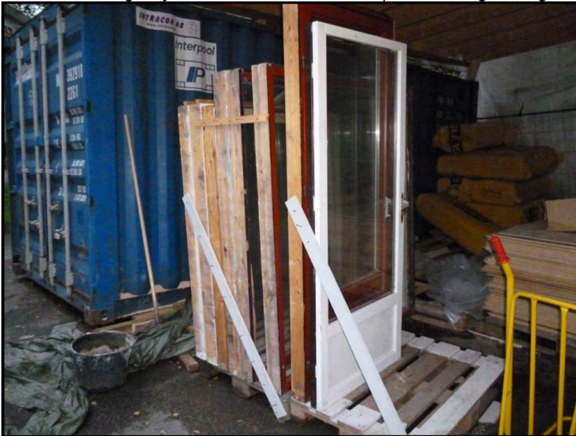
Figur 7: Slik kan vinduer og balkongdører klargjøres for transport.
