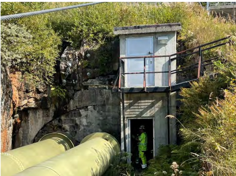
Figur 6 Betong ved tunnel til rørbruddskammer.
