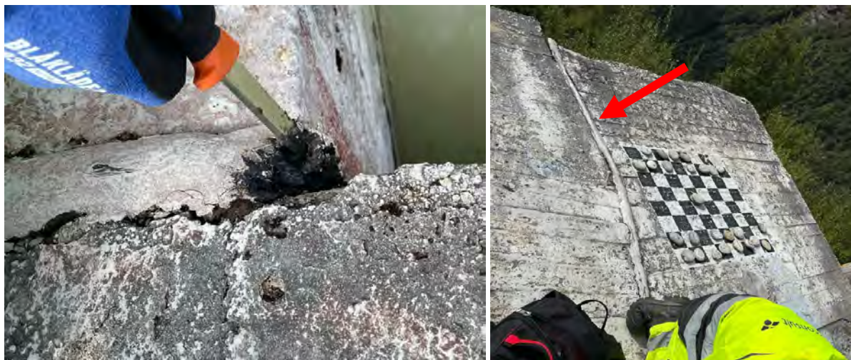
Figur 2 Fugemasse i kloss nr. 2.
