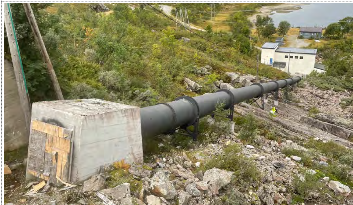
Rest av rørgate over kraftstasjonen.
