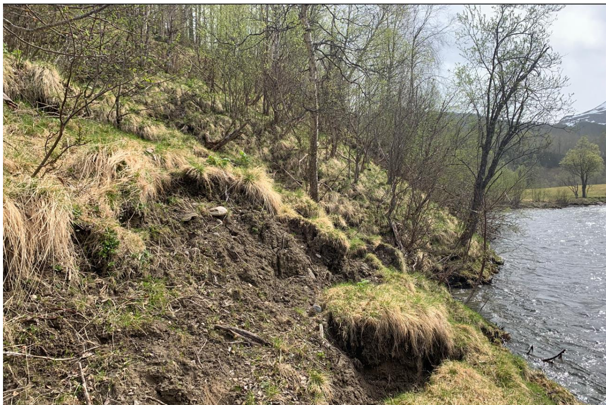
Figur 5.14 Bilde S26. Utglidning. Rundt 10 meter bred og 4 meter høy.
