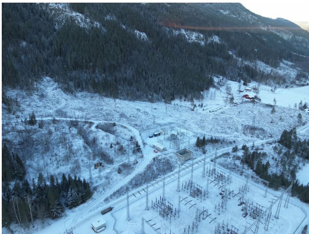
Bilde 4: Oversiktsbilde over deler av tiltaksområdet, tatt november 2025.
