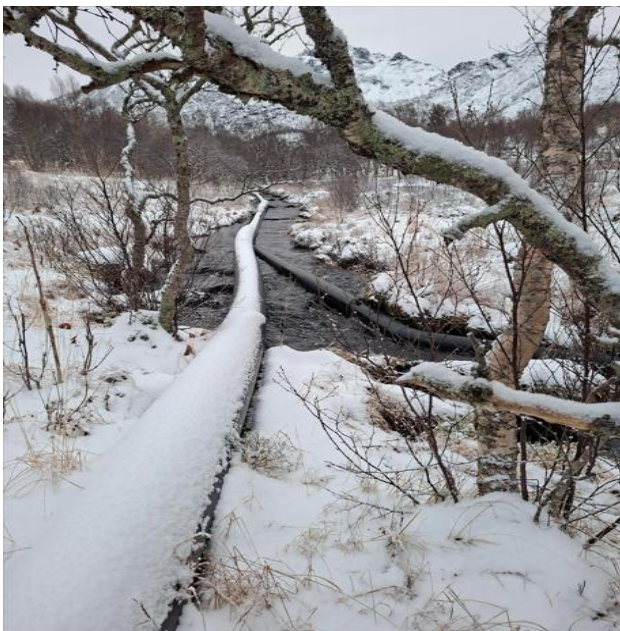
Figur 5, To stk PEH rør i Fabrikkelva
