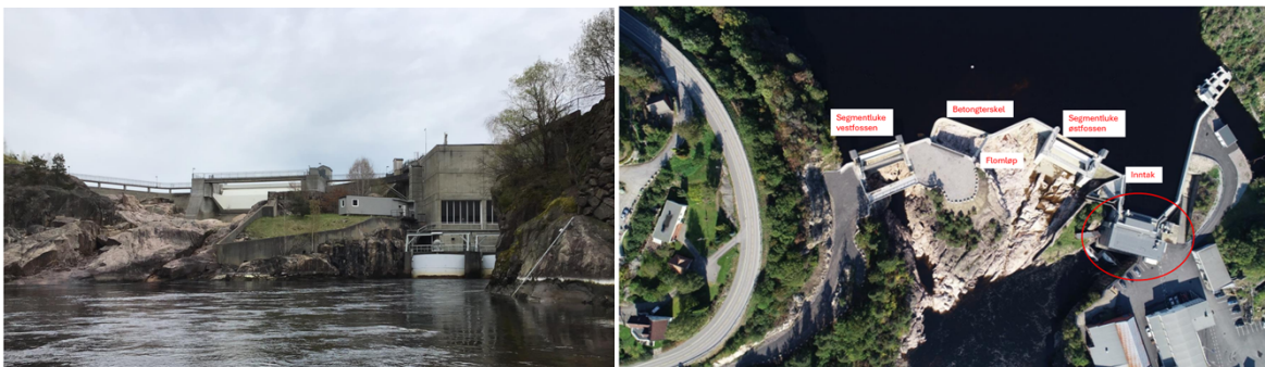
Figur 3. Bilder av Vigelandssjøfoss kraftverk nedenfra (venstre) og ovenfra med damanlegg (høyre). Kilde: Hydros konsesjonssøknad.
