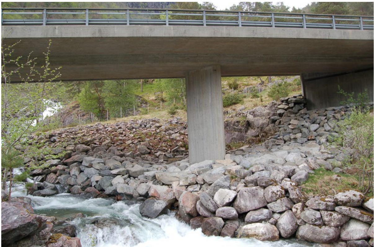
Brua, sett fra vestsiden av Kvernhuselva
