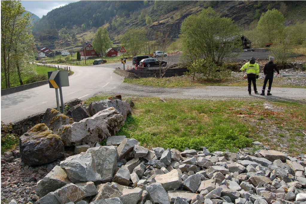
Står på RK-1 og ser på riggområde RK-2 til høyre og kraftstasjonen til venstre i bildet
