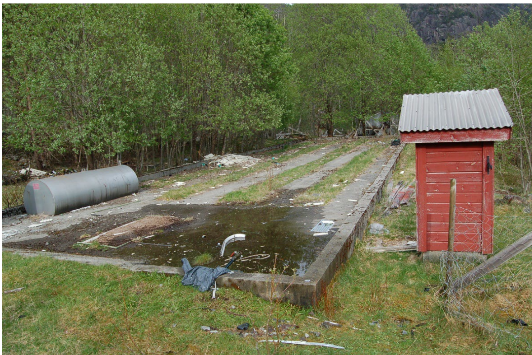
Øvre del av riggområde RK-2, fundament for gammelt drivhus
