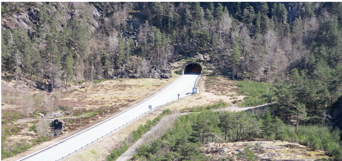
RK-5 ligger til høyre for E134, bilde tatt med drone 16.04.2024
