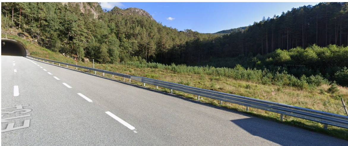
Riggområde RK-5, sett mot sydvest, Street wiew
