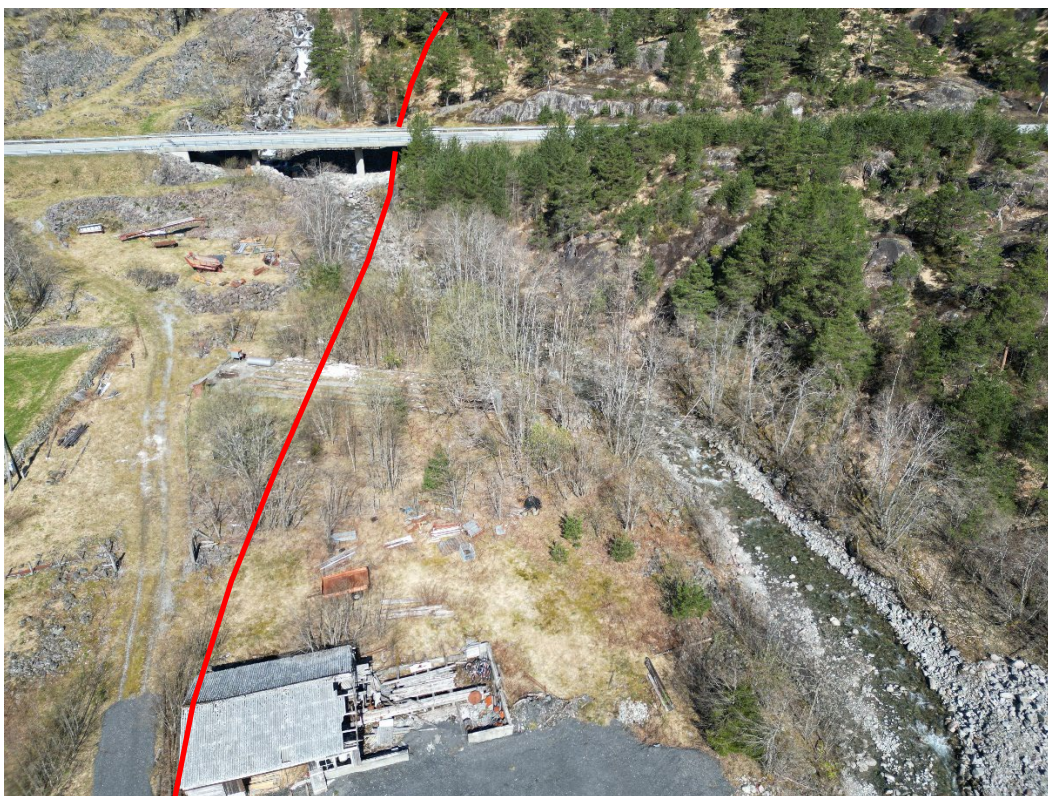
Oversiktsbilde fra brua og plassering av elvekryssing med turbinrøret
