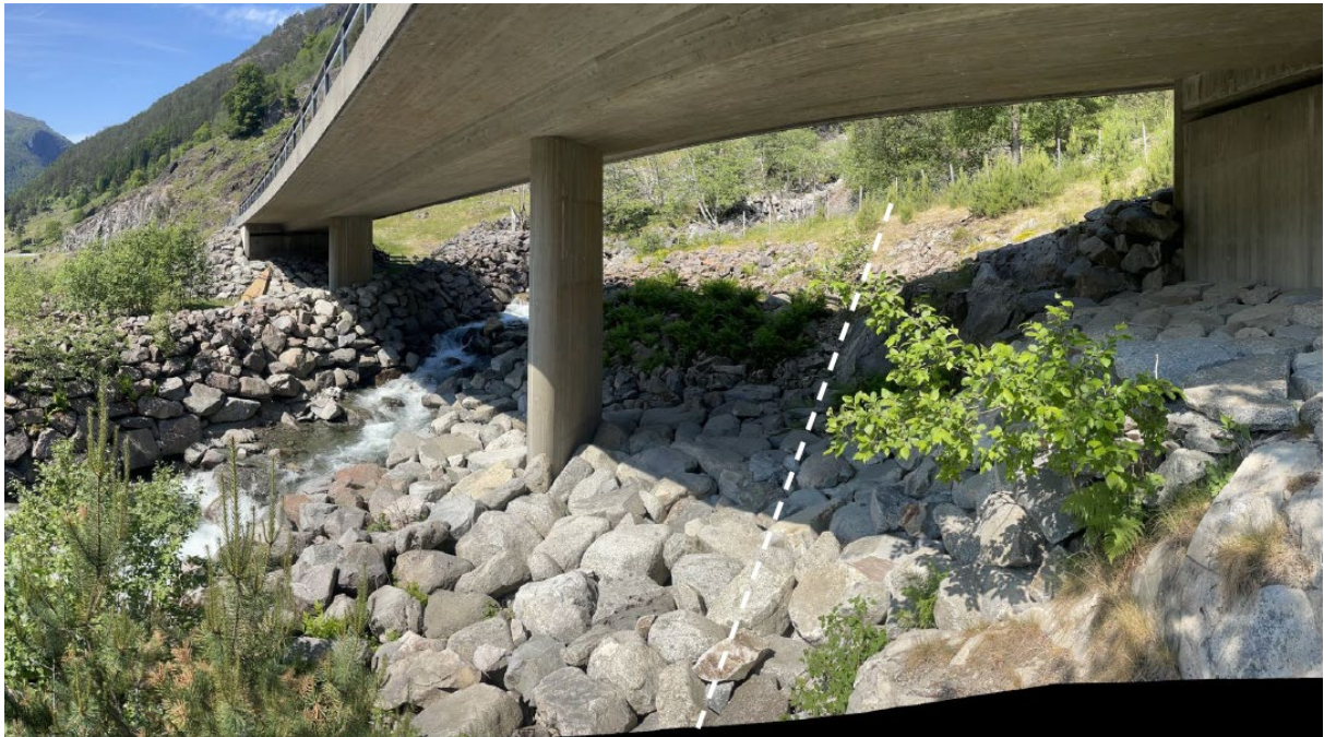
Kryssing av rørgate under ny bru
