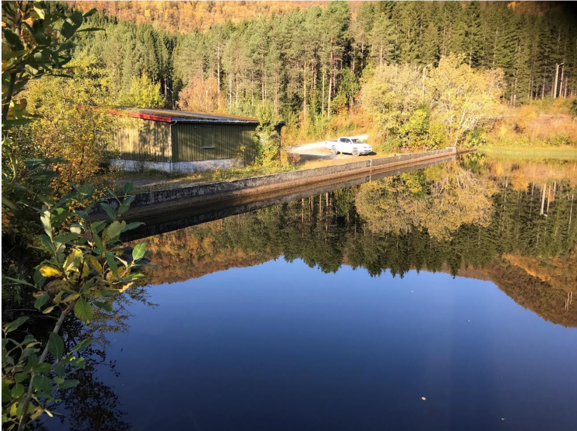
Oversiktsbilde 2 over dammen
