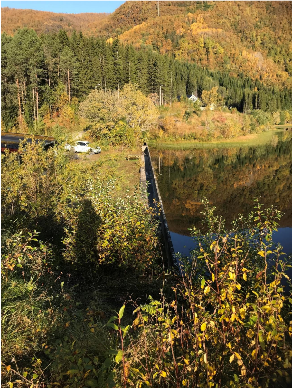
Oversiktsbilde 1 over dammen
