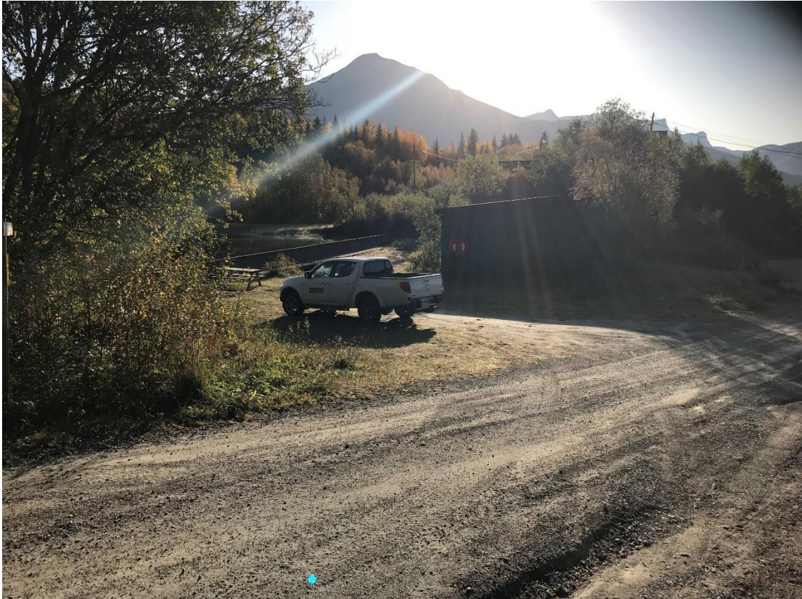
Oppfylling på nedstrøms side av dammen
