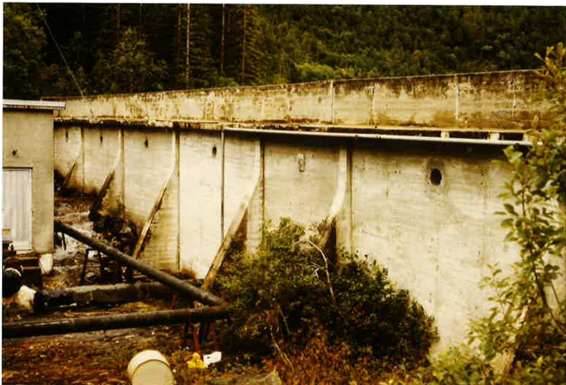
Dammen før oppfylling på nedstrøms side
