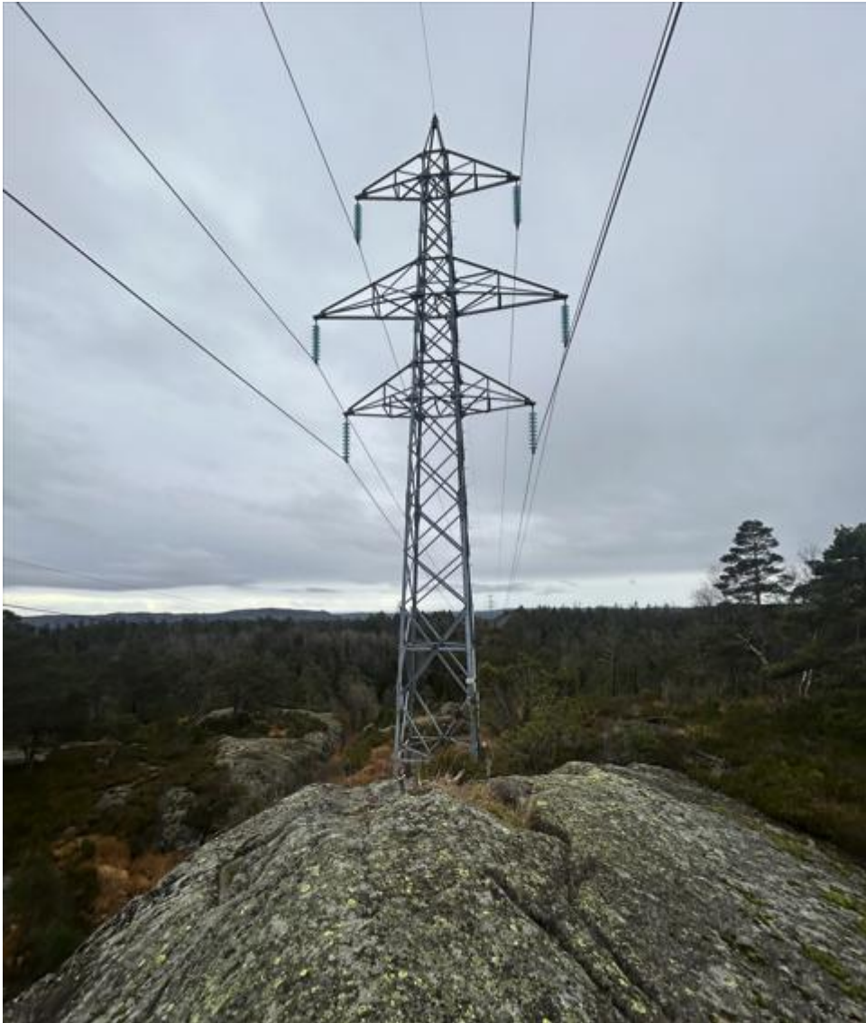
Figur 4-2: Mastetype som skal rives og flys ut med helikopter 110 kV Kristiansand - Krossen.
