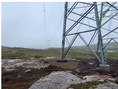
Figur 22: Her er sprengsteinsblokk fjernet fra overflaten.
