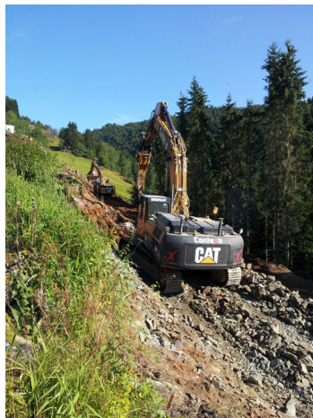
Figur 37: Opprusting av landbruksveg med stedege masser.
