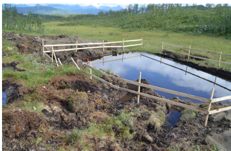
Figur 41: Etablert sedimentasjonsbasseng for håndtering av vann fra byggegrøp for mastepunkt. Bassenget fylles igjen etter bruk.
