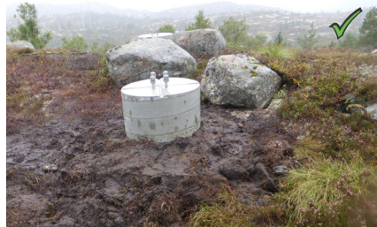
Figur 20: God overgang mellom stabbe og terreng.
