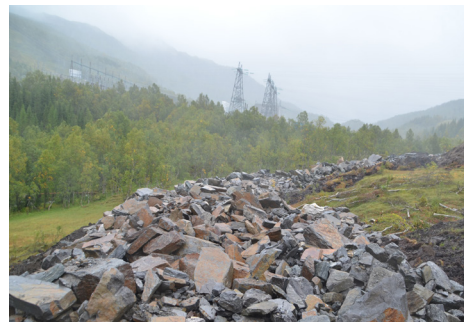
Figur 46: Motfylling for å forhindre at masser renner utenfor deponiområdet.
