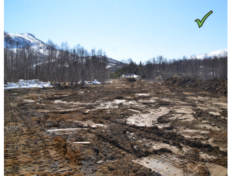
Figur 14: .Topplaget er skavet av og lagret i ranke til høyre i bilde. Massene skal benyttes ved istandsetting.
