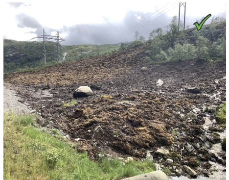
Figur 24: God istandsetting med rufsete overflate og plassering av naturstein på overflaten.
