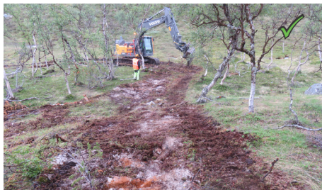
Figur 34: Ved uttransportering av maskiner og utstyr, skal kjørespor legges i gjenn og pusses. Gjennlagte spor skal ikke på nytt benyttes uten avklaring med Statnett
