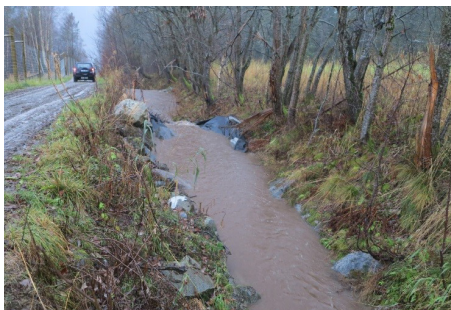
Figur 42: Eksempel der naturlig bekk er utnyttet ved å lage mindre demninger for å samle opp partikler fra vegbygging. Bassengene må tømmes regelmessig, og fjernes når avrenningen opphører.
