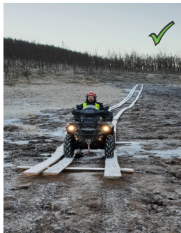
Figur 10: Eksempel på etablert terrengforsterkning over bløte partier.
