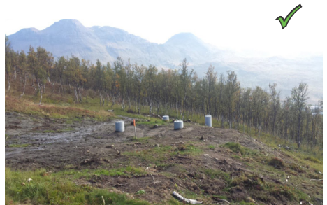
Figur 25: Toppmasser er lagt tilbake slik at naturlig revegetering kan starte. Massene er i tillegg lagt ut slik at overgang mellom omliggende terreng og punktet, blir naturtro.
