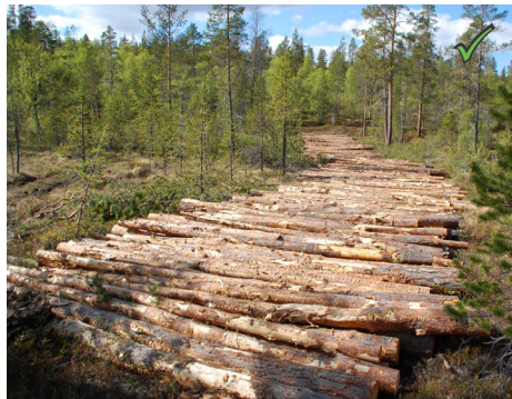
Figur 11: Eksempel på forsterket terreng i form av klogging med tømmerstokker.
