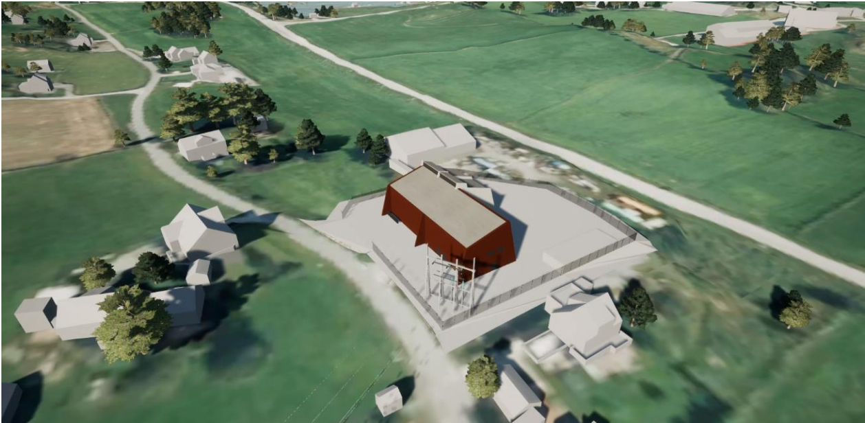
Figur 22 Nordbø transformatorstasjon alternativ 1B, sett fra sør
