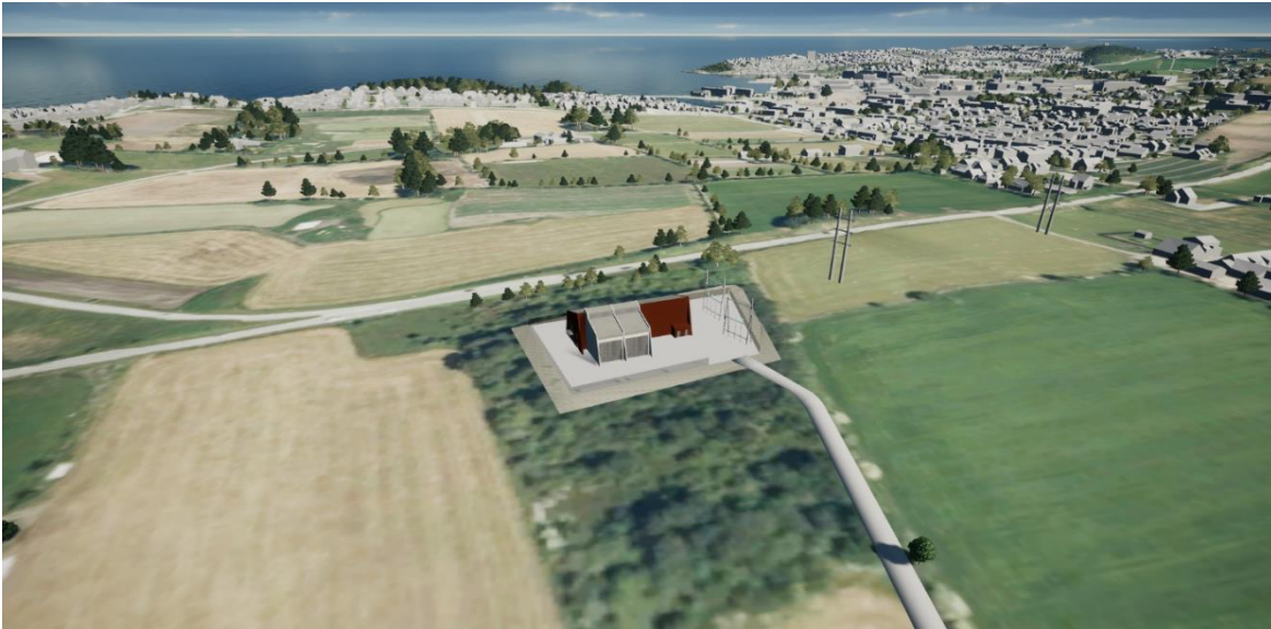
Figur 18 Harestad transformatorstasjon, alternativ 5, sett fra vest
