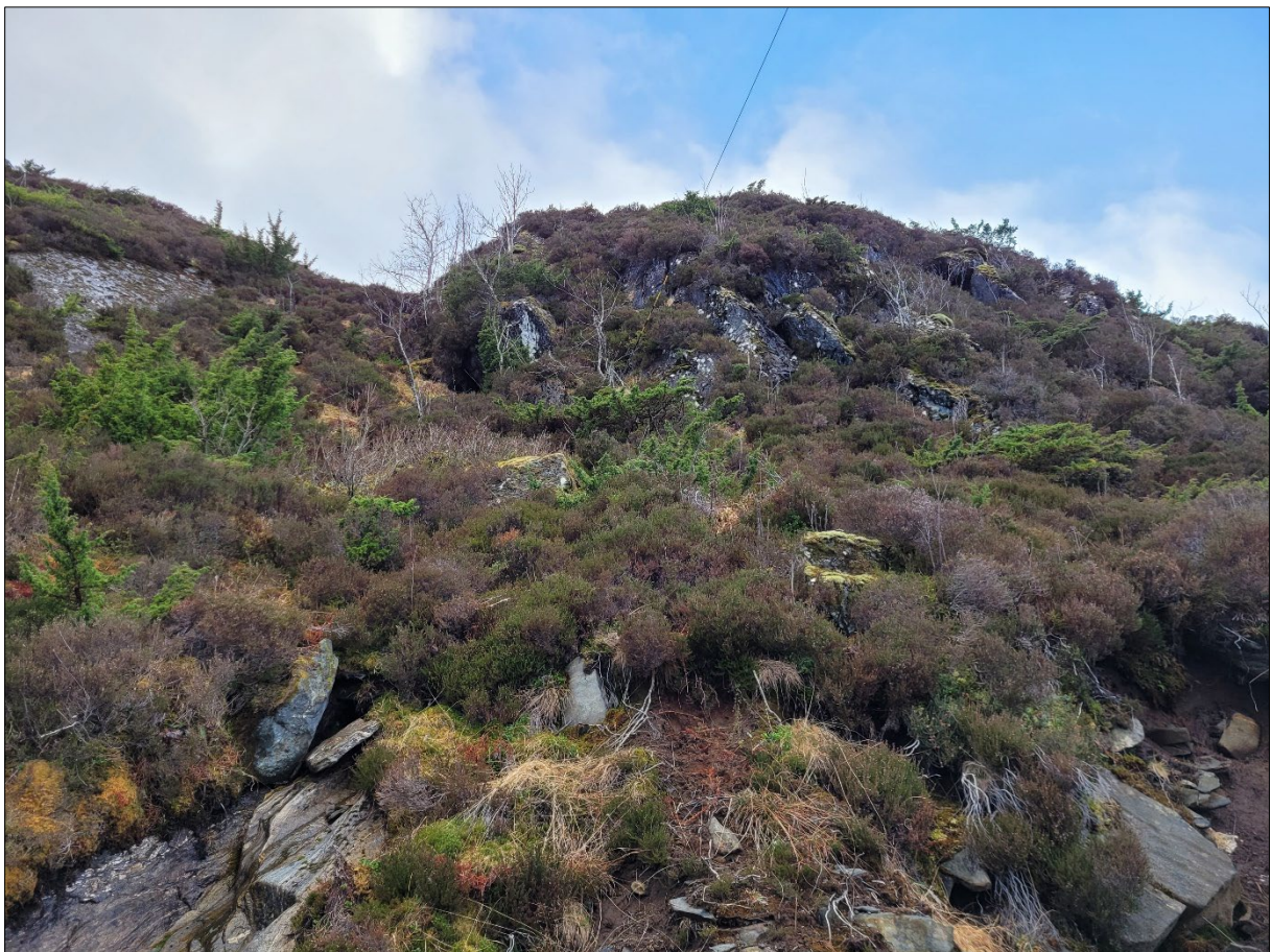
Figur 9: Bildet viser fjellhammer i nedre del av påvirkningsområdet hvor berggrunnen er mer oppsprukket. Fra dette området er det observert enkelte steinsprangblokker som havner tett på løснеområdet. Infopunkt 1
