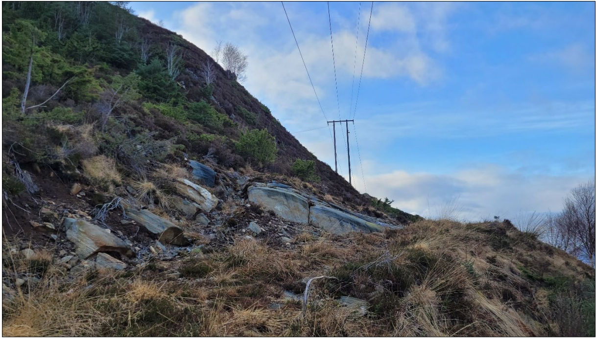
Figur 8: Bildet viser fjell i dagen av gneis som er massiv, lite oppsprukket og med glatt overflate. Bildet er tatt fra nedre del av påvirkningsområdet.
