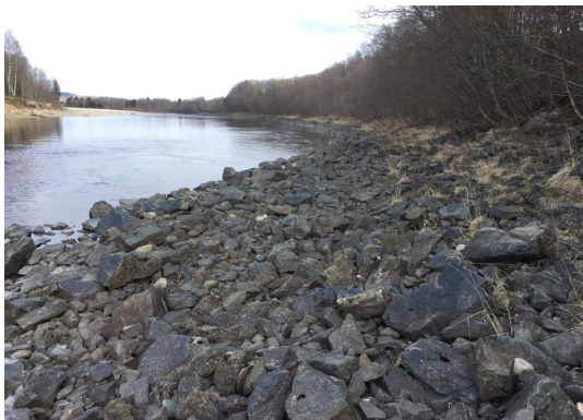
Figur B5: Erosjonssikring langs Gaula.
