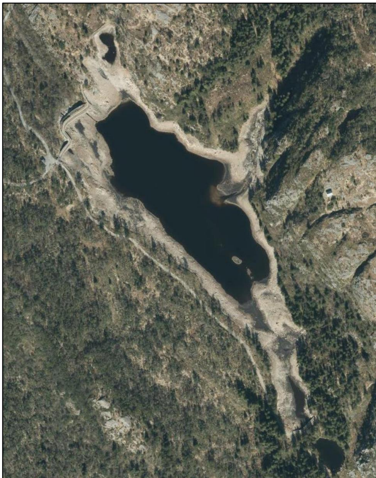
Figur 3-2. Flyfoto av vannet nedtappet. Ved nedleggelse av vassdraget er det omtrent på dette nivået vannet vil etablere seg.
