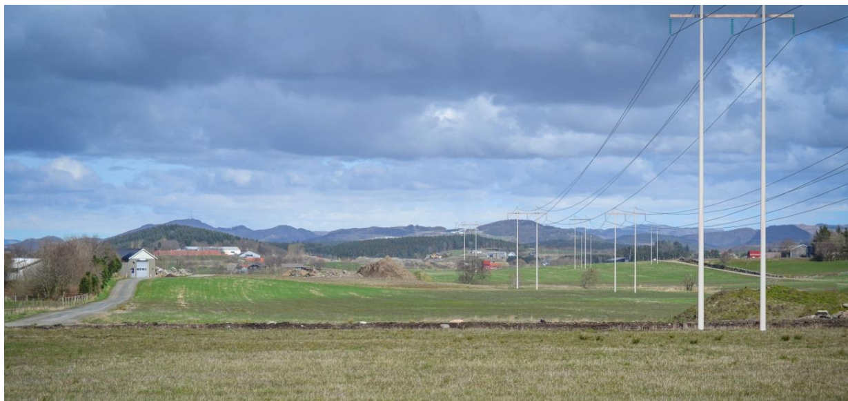
Figur 6.2. Gruda, to enkeltkurser sett mot nordøst.
