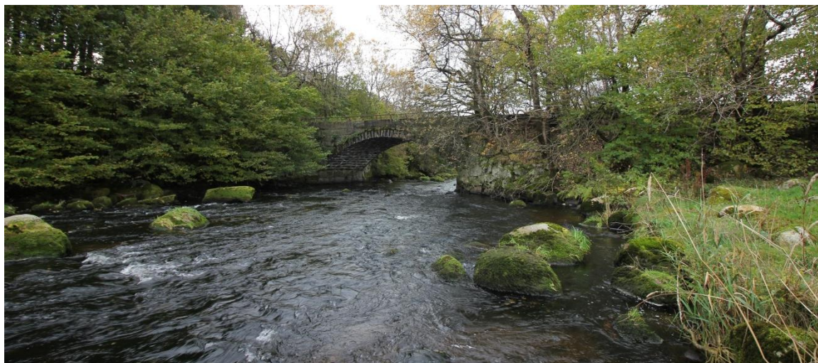
Figur 6.83. Fosse bru, bygd 1898. Mot sørvest.
