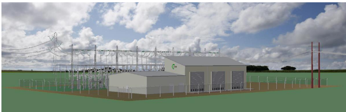
Figur 5.1. Prinsippskisse av utendørs, luftisolert (AIS) transformatorstasjon
