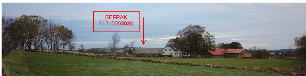
Figur 6.73. Tunet på Holen gbnr. 21/1, med eldre smie/verkstadbygg (SEFRAK 11210003030), midt i bildet. Mot nordvest.
