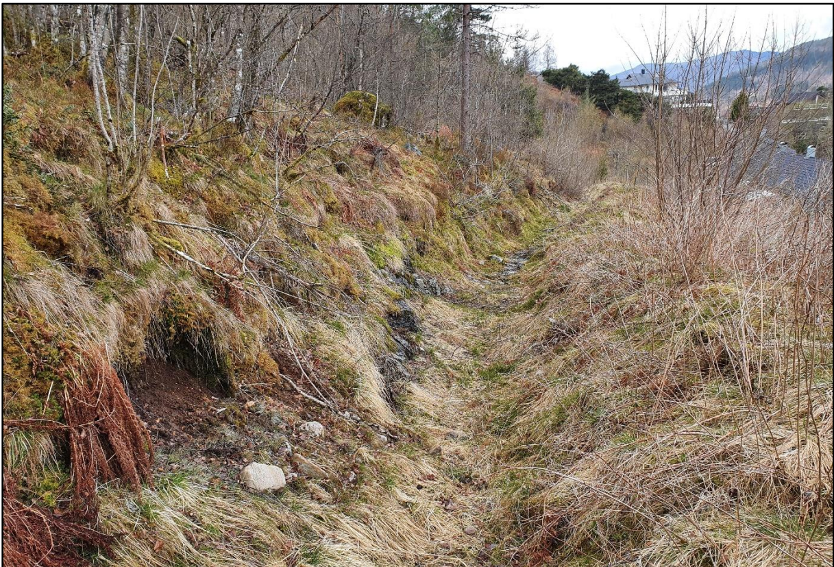
Figur 15: Bilete tatt mot nord/nordvest. Der er utarbeidd ein 1,0-1,5 m høg voll i overkant av Kjørslemøbakkane burettslag og denne fangar opp overflatedreneringa mellom dei to bekkane i påverknadsområdet.
