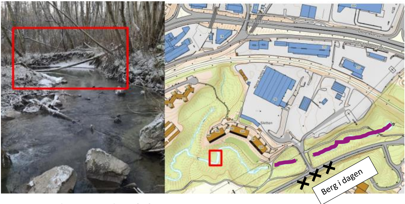
Figur 18: Bilder fra erosjonsbefaring [10]
