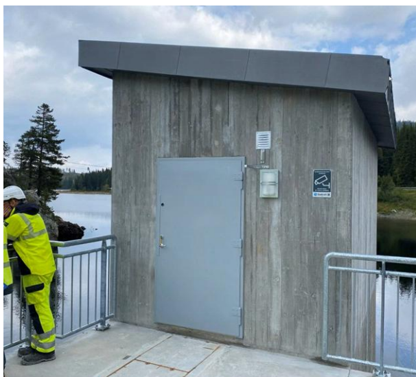
Figur 3.1 Lukehus ved dam Vågi.
