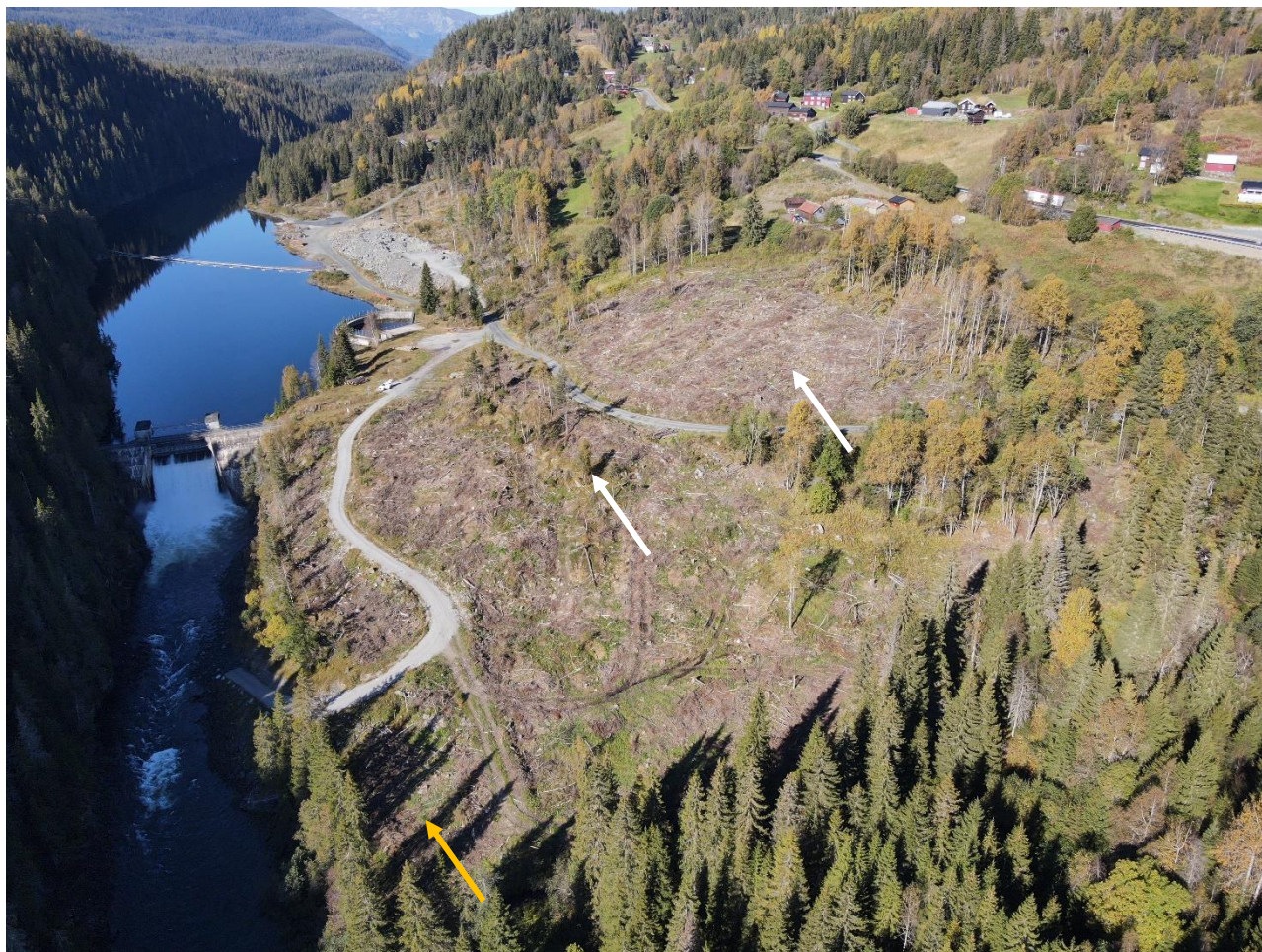
Figur 7. Dronebilder tatt etter nylig hogst i området (datert 20.09.2024). Nye permanente plasser for grunneier er planlagt nord for grusveier (se hvite piler). Plastret omløpskanal er planlagt sør for svingen på grusveien (se gul pil).
