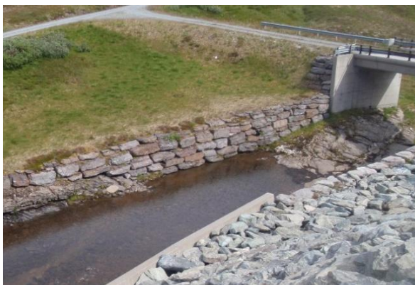
Figur 3.5 Venstre: Flomløpskanal hoveddam Kvilestein. Høyre: Flomløp dam Bordalen.
