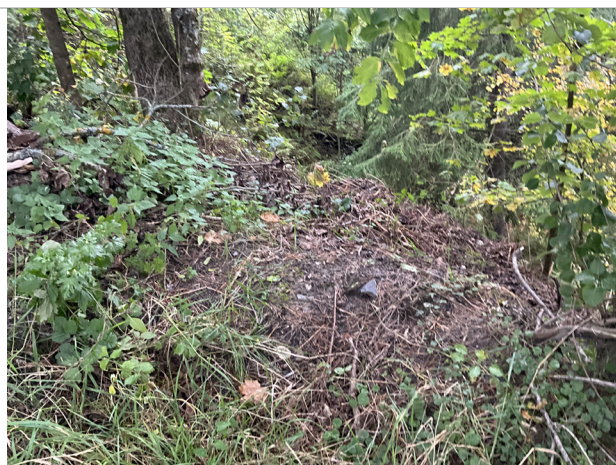
Bilde 14. Fylling ved skråningskanten (bør unngås)
