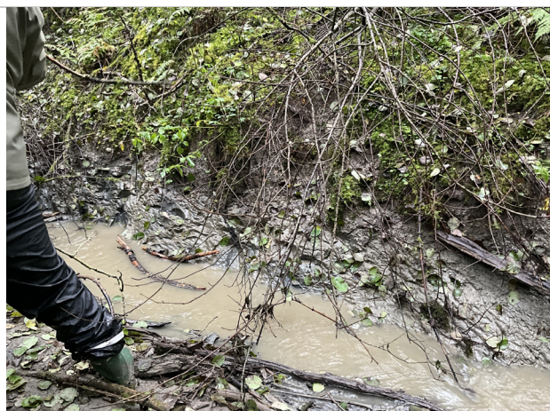
Bilde 8. Erosjon/nedgraving av bekken i leire
