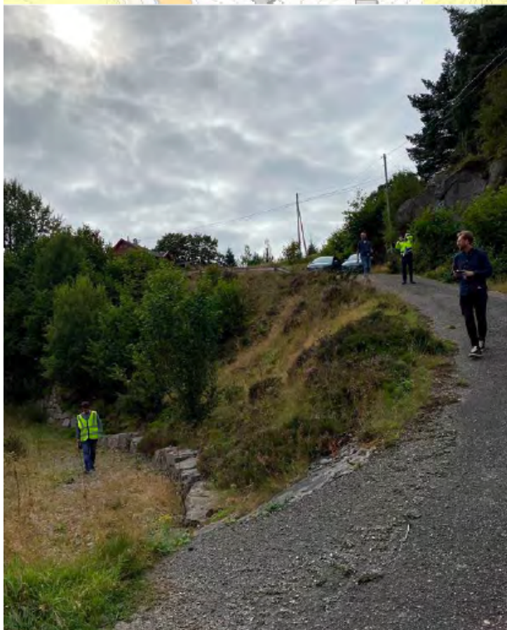
Figur 8: Støttemur ved Dalsvågen.
