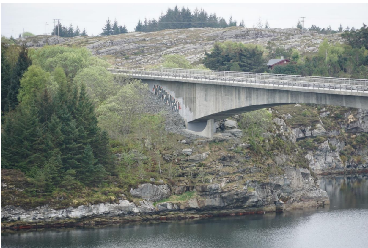
Figur 10: Kabelinnføring Svelgen bro.
