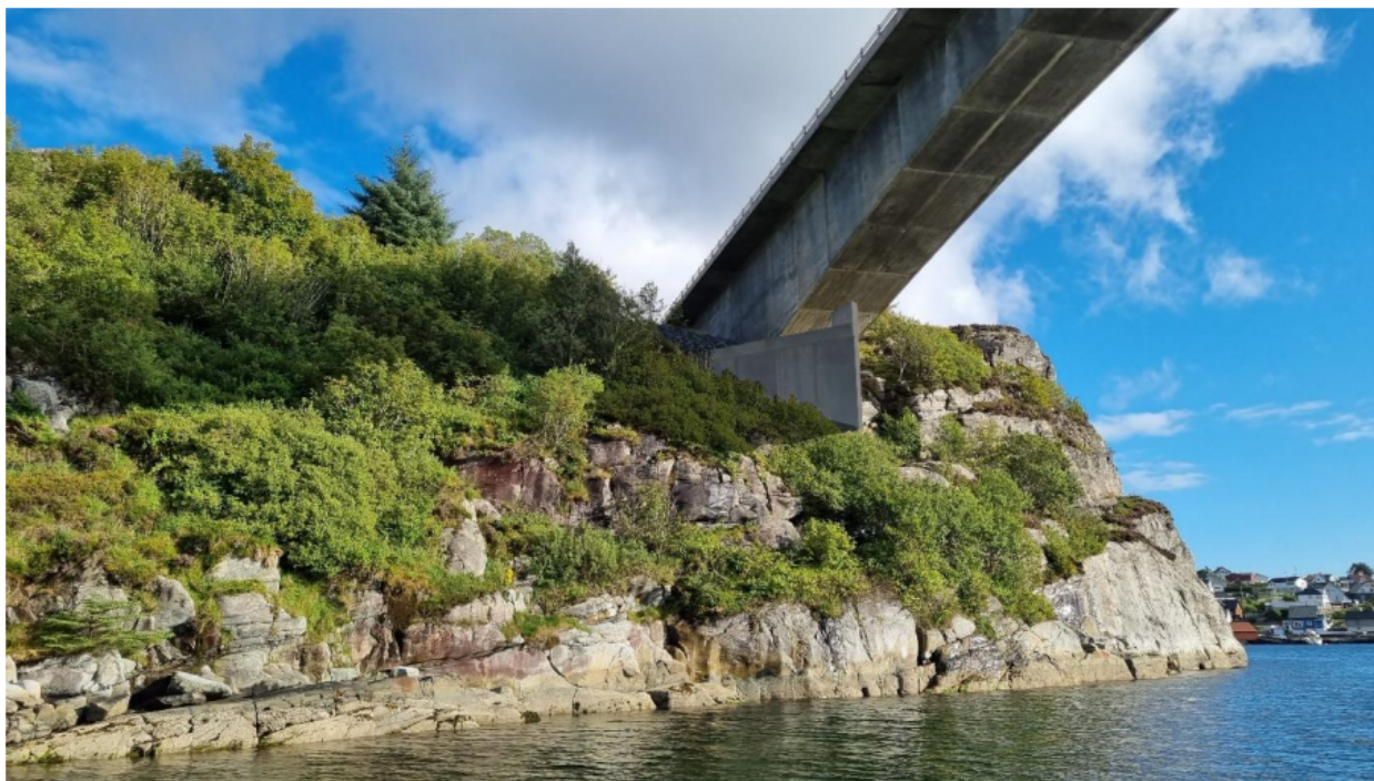
Figur 9: Kabelinnføring Solsviksundet bro.
