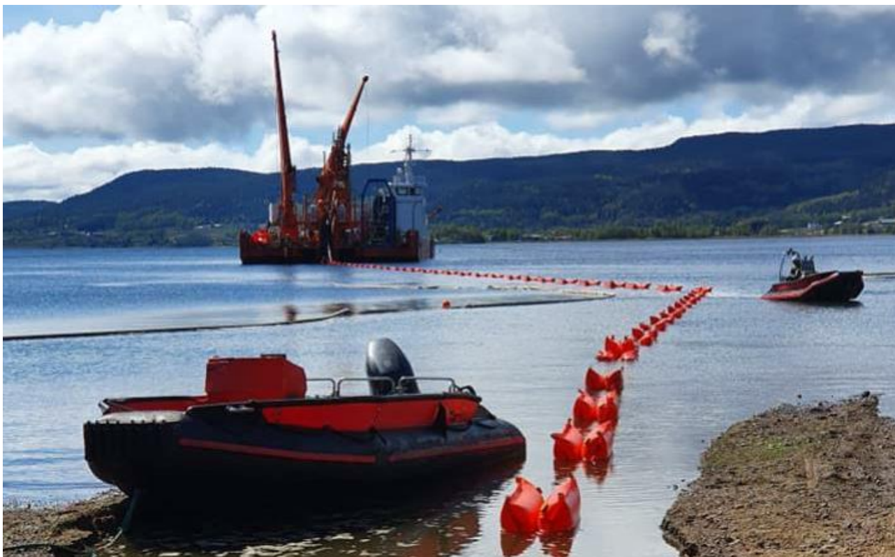
Figur 5-8. Eksempel på kableggingsfartøy og ilandføring av kabel. Foto: Seløy Undervannsservice.
