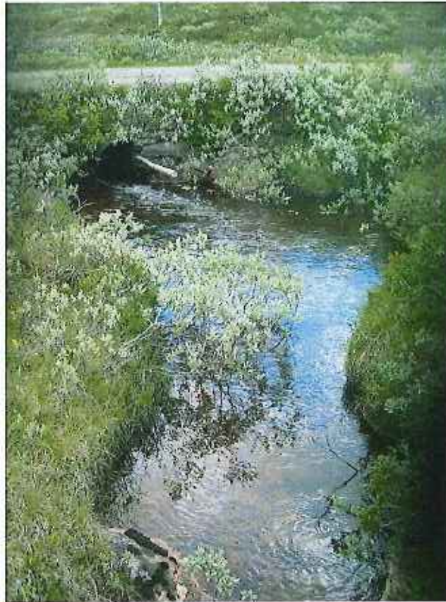
Mulig vandringshinder for ørret ved lav vannstand, og absolutt vandringshinder for ørekyte der bekken går i rør under veien.
