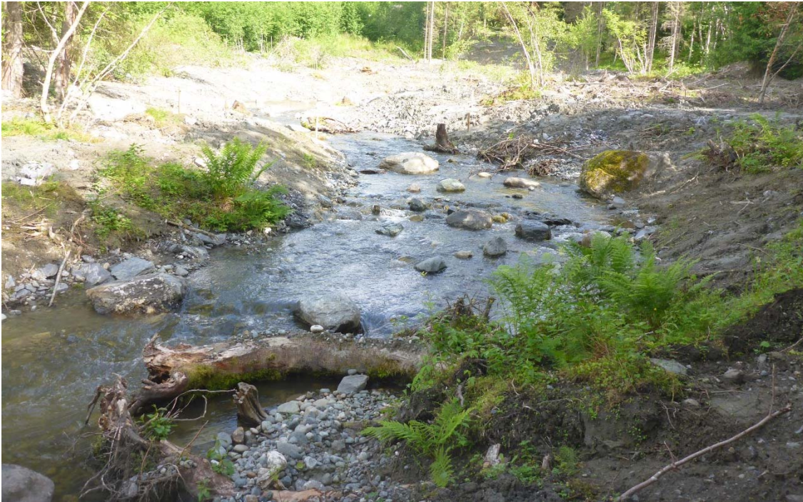
Figur 25: Eksempel på plassering av stein- og stokker i Hofstadelva etter sikringsarbeidet er gjennomført (Foto: A. J. Kjøsnes, NVE)
