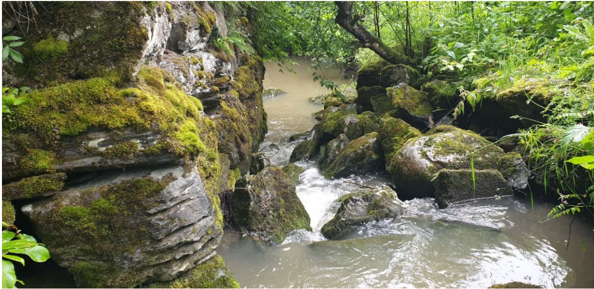
Figur 10: Det gamle brukaret må fjernes for å gi bekken bedre flomkapasitet
