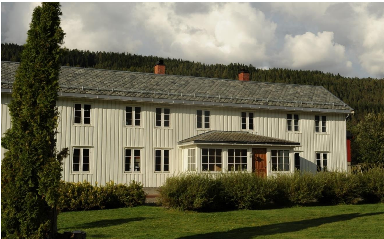
Figur 4-11. Gamle gårdshus like øst for Oppvekstsenteret på Mo, på nordsiden av veien.
