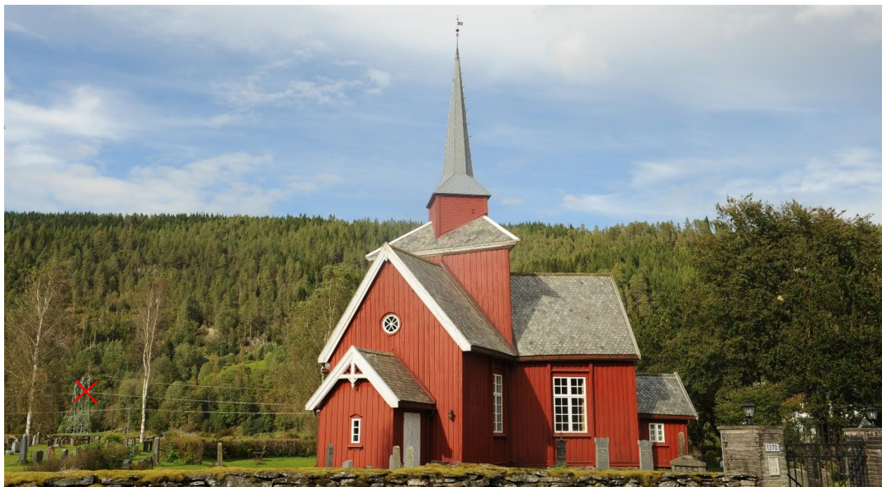
Figur 5-6. Rødt kryss viser mast som skal rives bak Mo kirke.
