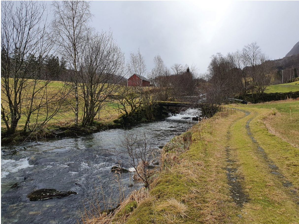
Figur 3: Slak elv med steinsatte skråninger. Ingen tegn til erosjon. Fjell i dagen under brukar. Bilde tatt mot aust.
