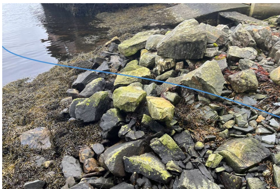
Figur 13 Landtak for sjøkabel.
