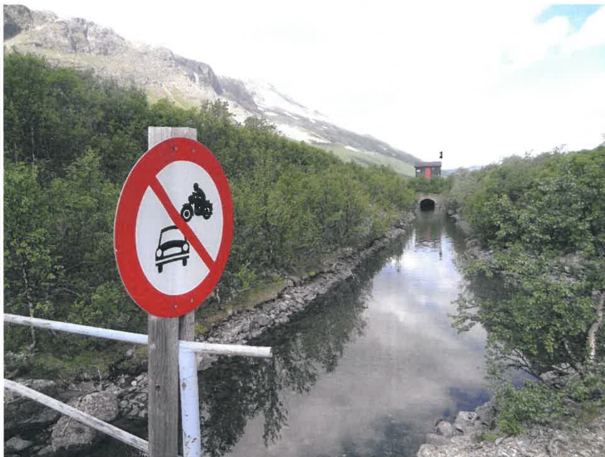
Bilde 5: Buaråni nedstrøms dam. Elva er kanalisert i nytt løp, da Helin er et senkningsmagasin.
