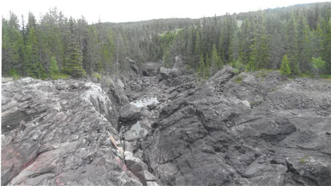
Bilde 1: Nedstrøms dam Bløytjern.
