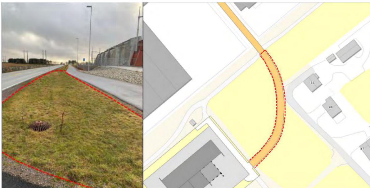
Figur 25: Venstre: gressmatte lagt over vei for spesialtransport. Høyre: del av adkomstvei der det er aktuelt å bruke gressmatte. Kilde: Konesjonsøknaden.
