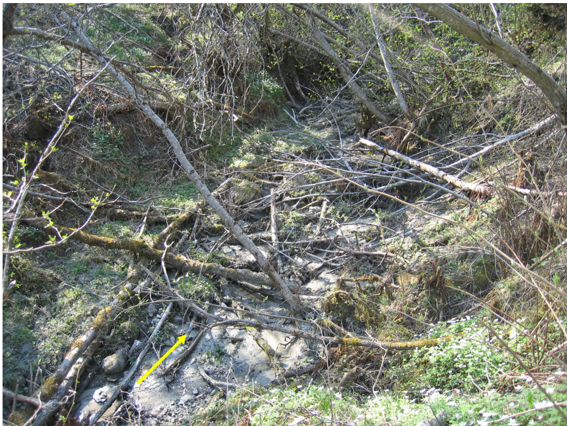
Bilde 15 Sidebekken sett nedstrøms retning (ved tverrprofil P8)
