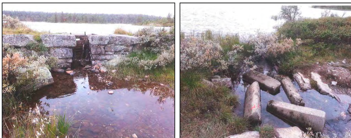
Figur 2 Bildet til venstre viser dagens murdam i Svintjønna. Bilde til høyre viser dagens naturlige overløp i Svintjønna.
