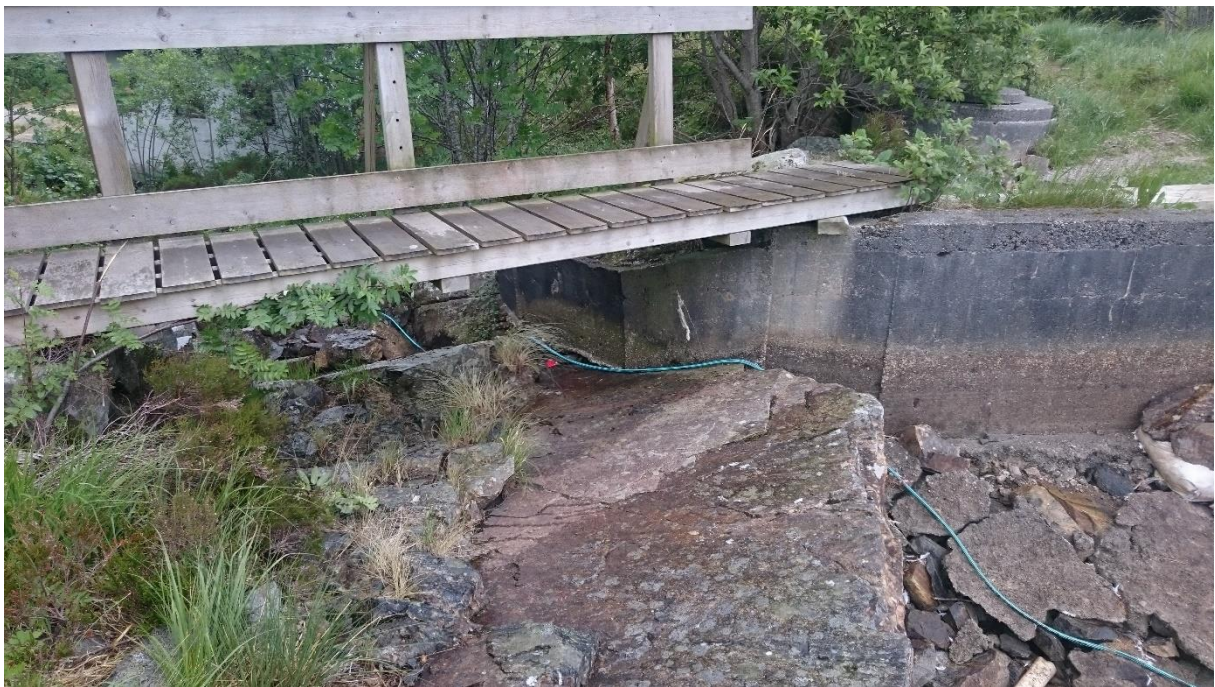
Bilde 7 Opprinnelig overløpsterskel i terrenget under bru. (14.07.16)
