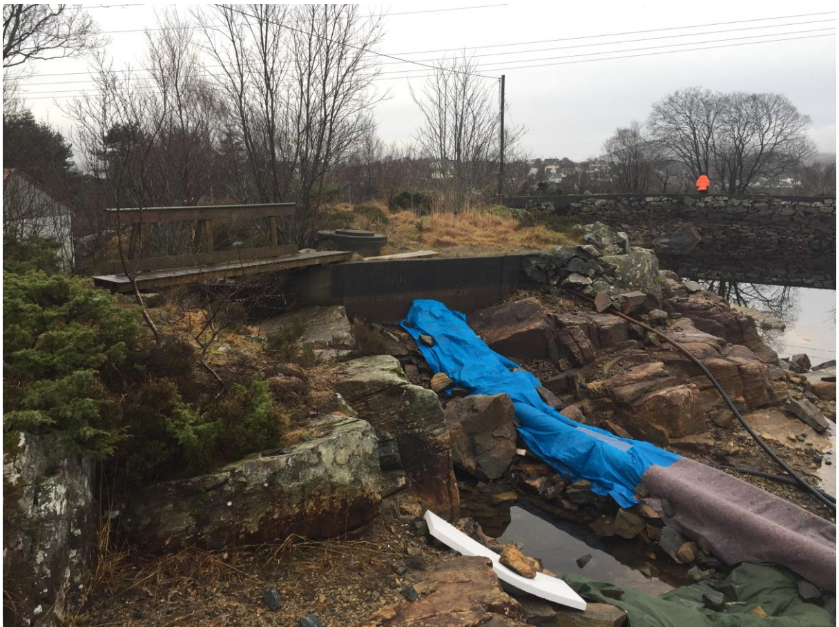
Bilde 6 Hoveddam, sidedam og opprinnelig overløpsterskel i terrenget under bru. Rørledning (med blå plast) er eid av Fjellvar og krysser Storavatnet. (09.12.16)
