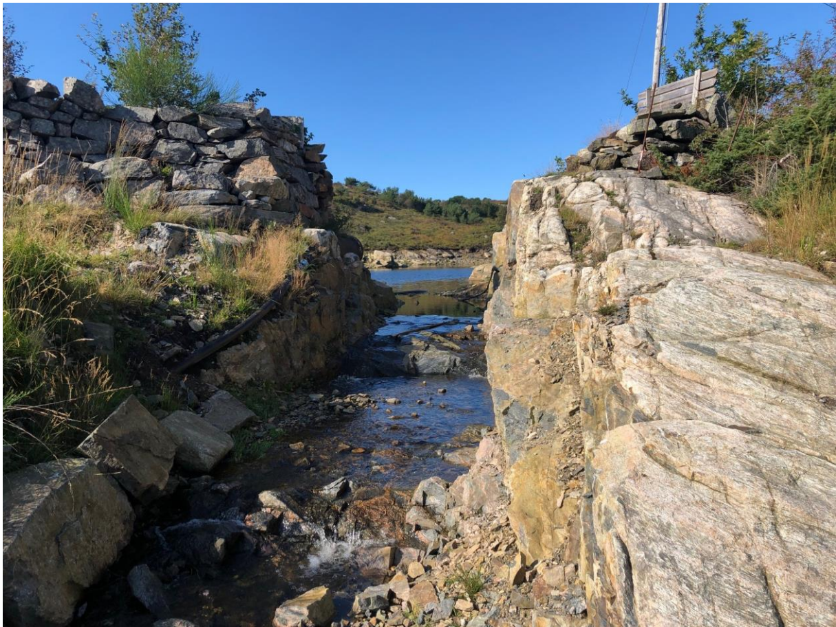
Bilde 8 Ny kanal og overløpsterskel gjennom sidedam etablert i 2017 (09.2019)
