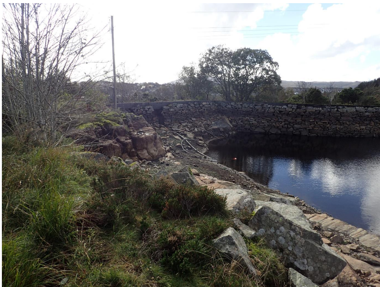
Bilde 2 Hoveddam med sidedam til venstre. Bilde viser oppstrøms side av dam. Tele/ el mast er også vist. Bilde er tatt mot sør- øst. (26.09.16)
