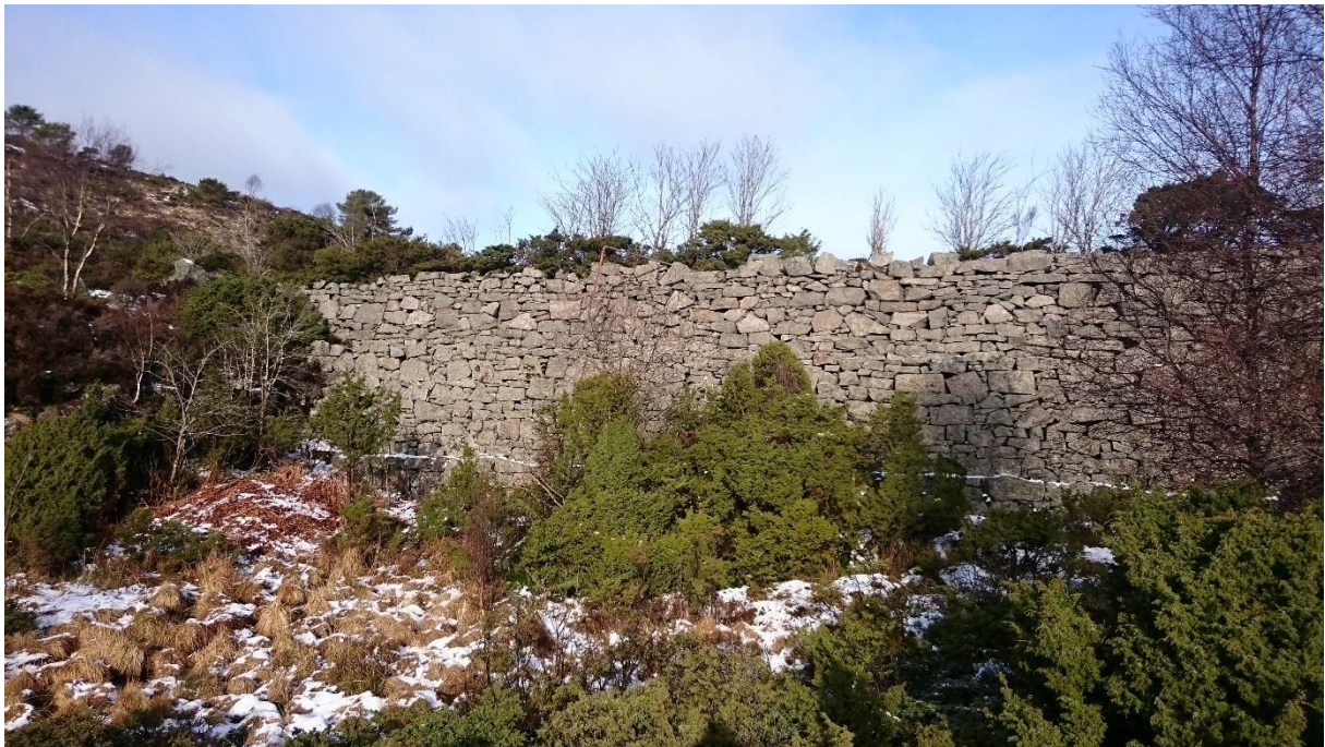
Bilde 3 Hoveddam Storavatn. Bilde viser nedstrøms side av dam. Bilde er tatt mot nord- vest. (25.02.16)
