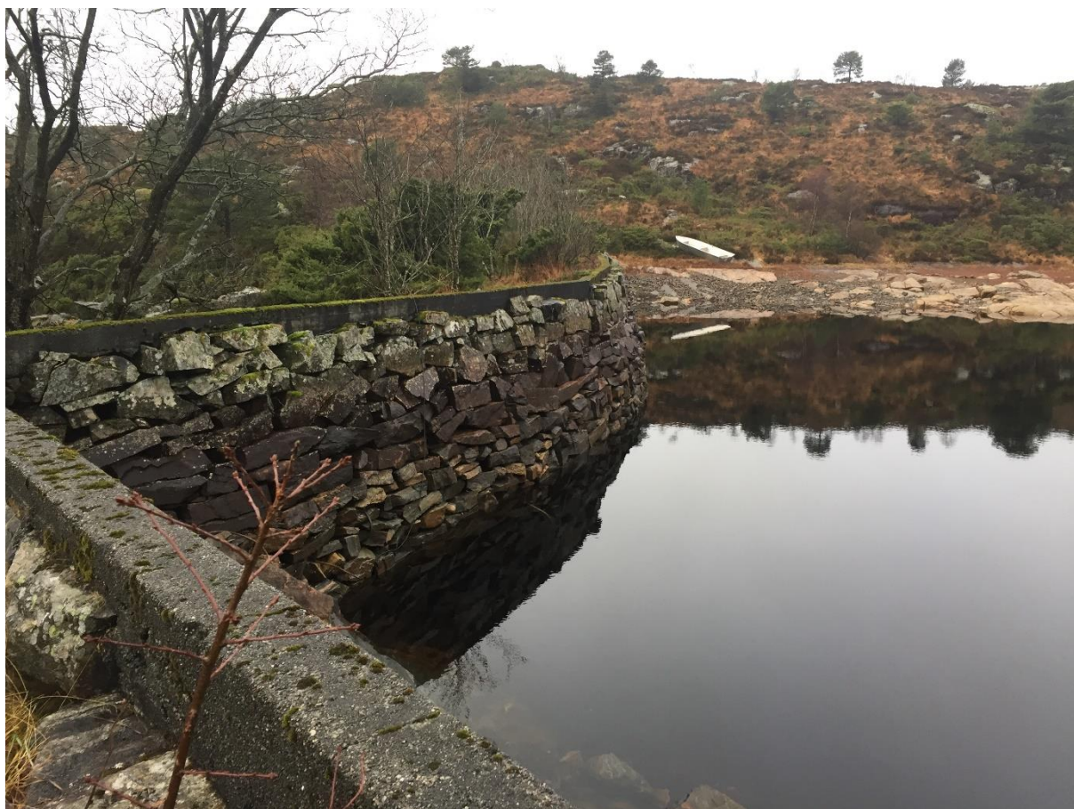
Bilde 1 Hoveddam og topp av sidedam. Bilde viser oppstrøms side av dam. Bilde er tatt mot sør- vest. (09.12.16)
