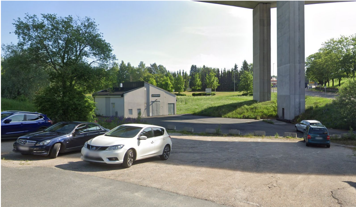
Bilde 2-1 Betongbygget er eksisterende pumpestasjon. Kommunen har et større areal rundt denne, og som vil brukes som riggområde for kabelanlegget. Mye av arealet vil også etter kabelanlegget blir gravd ut for pumpestasjonen.
