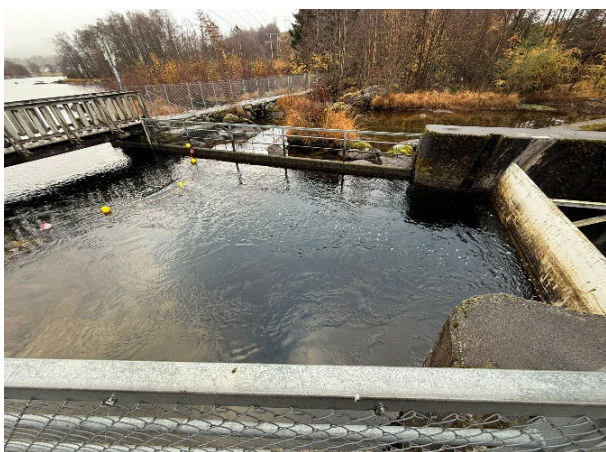
Figur 3: Dam, Bjørheimsvatnet (Foto: Småkraftkonsult)
