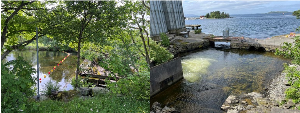
Figur 4. Venstre: Dagens kraftverksinntak i Krossvatnet (Foto: Småkraftkonsult). Høyre: Avløpet fra Tou kraftverk (Foto: Småkraftkonsult).
