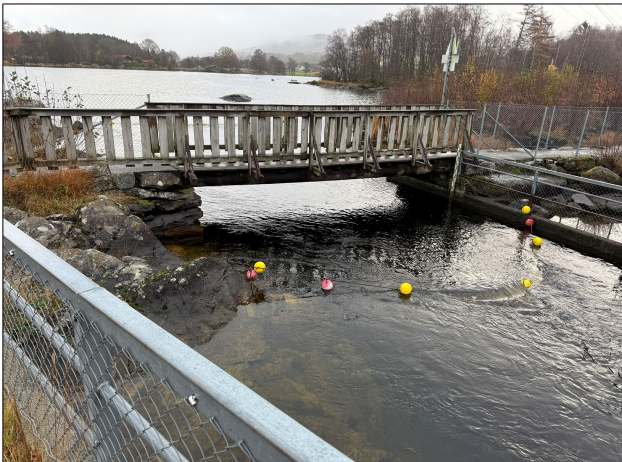
Figur 22: fjell ved reguleringsluke Bjørheimsvatnet (Foto: Småkraftkonsult)
