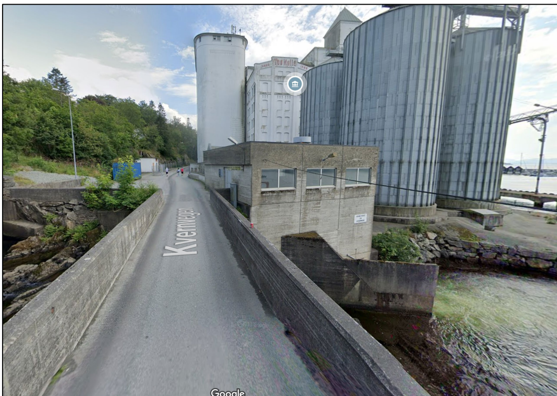
Figur 24: kraftstasjon (Foto: Småkraftkonsult)
