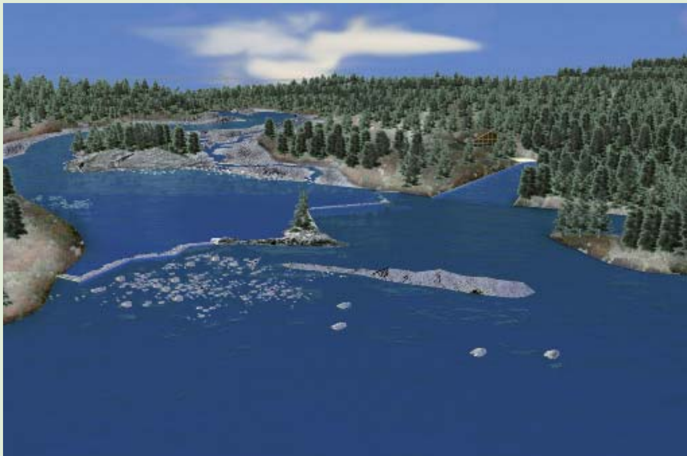
3d-visualisering som viser ny terskel, inntakskanal og dagbygg ved Nedre Svangtjønn (Visualisering: Sweco AS, Frode Sætre)
