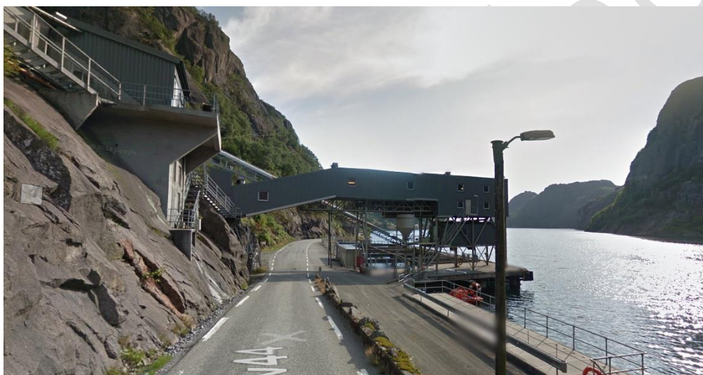
Figur 7-16: Teknisk installasjon og byggverk med karakter og som tilfører landskapsbildet en spennende kontrast. Kilde: Fv44 - Google Maps
