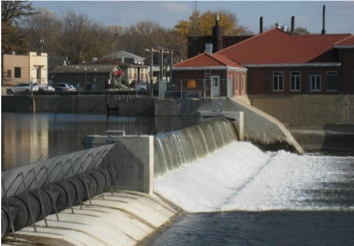
Figur 4-4: Obermeyer luke. Ved venstre luke kan den oppblåste gumnipølsen sees med lukebladet liggende over. Luken til høyre er noe senket slik at vann renner over (foto: Obermeyer Hydro, Inc.)
