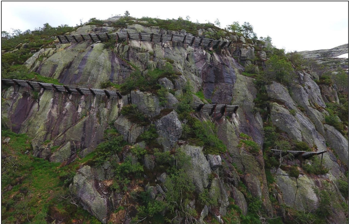
Figur 27: Dronebilde av delområde 6 (nordre del), med støtteforbygninger fra 1950-tallet.
