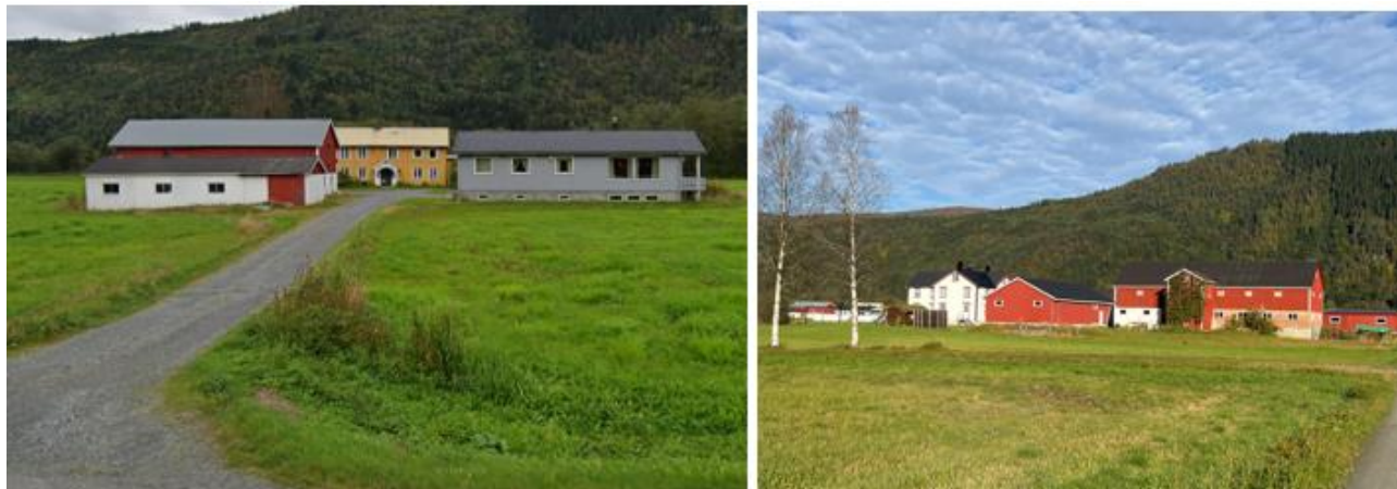
Figur 5-18. SEFRAK-registrerte våningshus på Nordigard (gult bygg til venstre) og på Honnstadøyan (hvitt hus).
