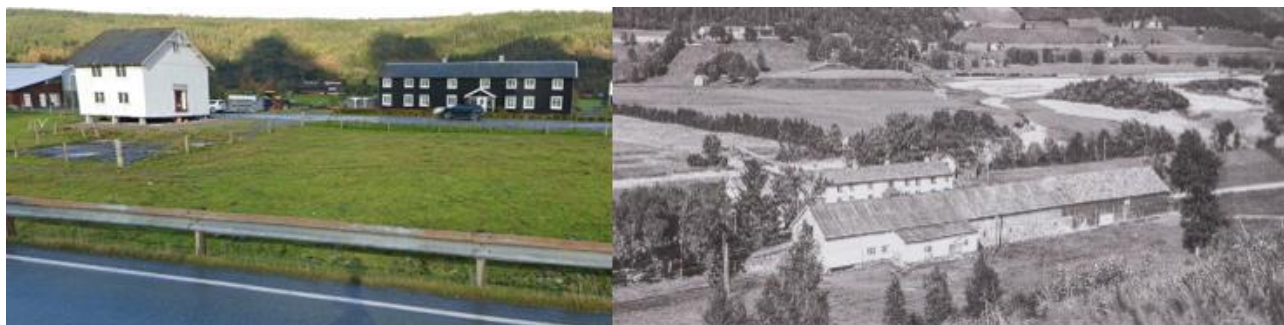
Figur 5-9. SEFRAK registrert stabbur og våningshus på Øvre Setra, trolig bygget på 1700-tallet. Våningshuset er malt til svart i motsetning til den opprinnelige hvitfargen. Fjøset lå på jorden rett ved riksvei 65, se bildet til høyre [7].
