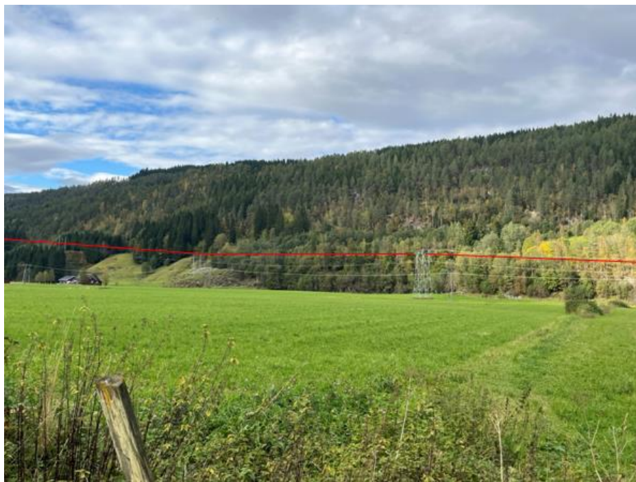
Figur 6-3. Utsyn fra delområde 5 mot ledningen som skal saneres (rød strek).
