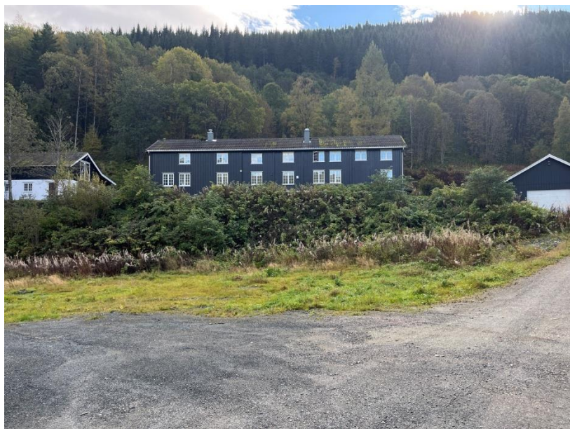
Figur 5-10. Våningshuset på Seterøya. Tatt mot sør.
