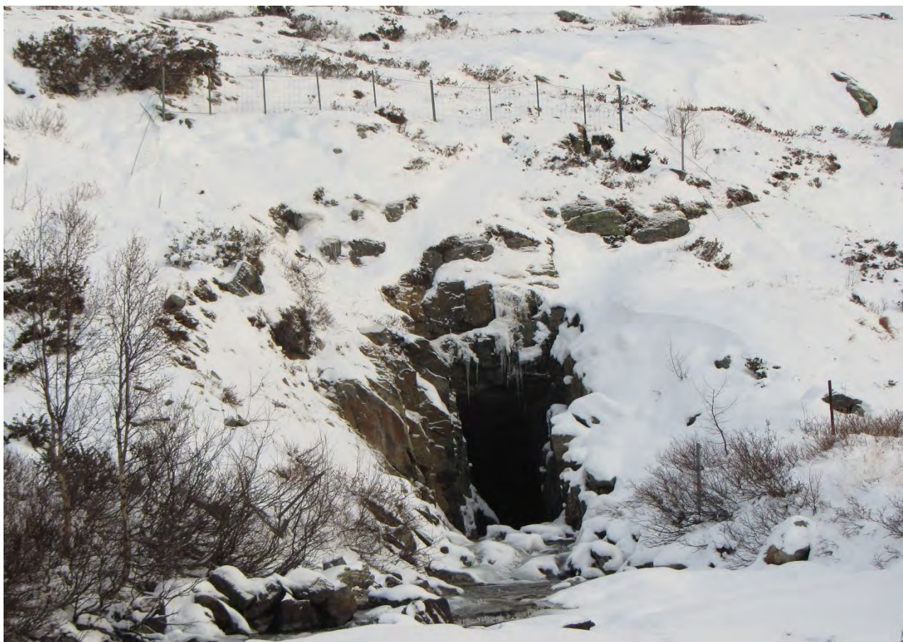
Bilde 1 - Munning av tappetunnel mellom Bergsjø og Rødungen
