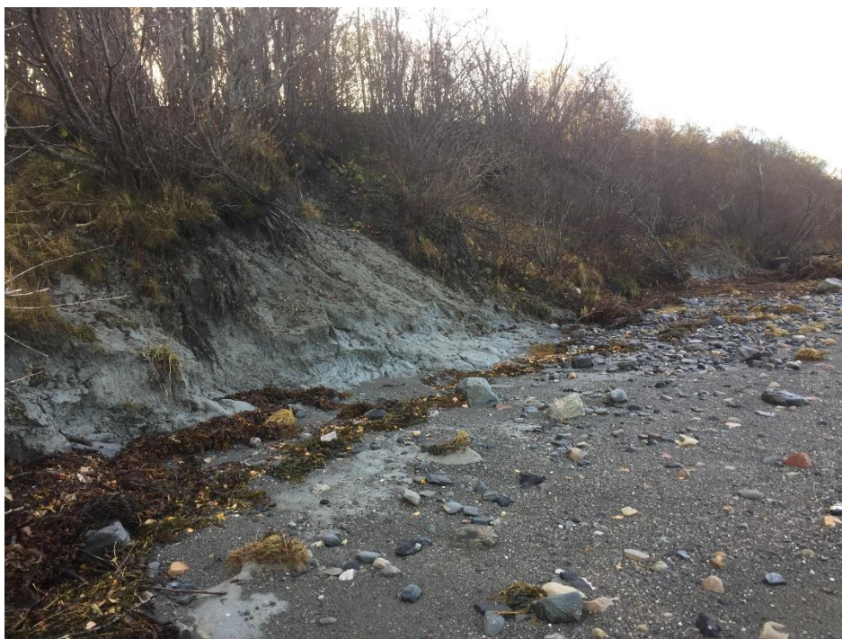
Figur 7: Det er svært bløtt i strandsonen, og flere spor etter erosjon og utglidninger. Erosjonssikringen vil bidra til å hindre ytterligere erosjon som kan forverre stabiliteten og potensielt utløse kvikkleireskred.
